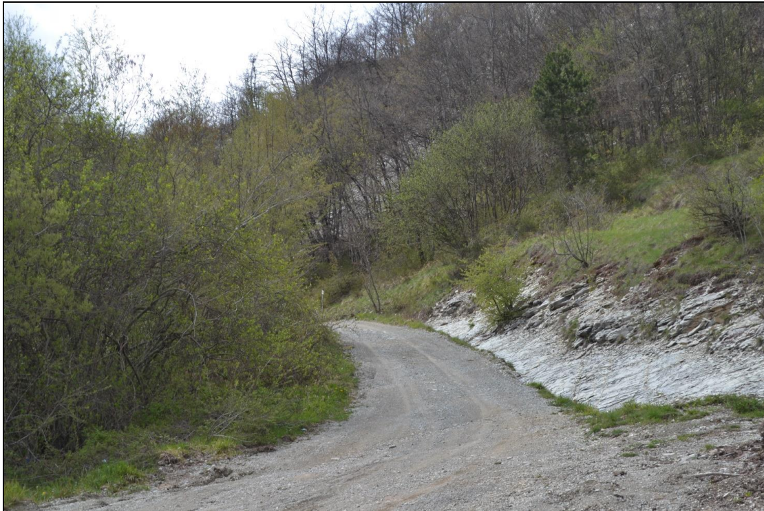
Figura 23. Dettaglio della strada sterrata compresa tra AE04-AE05 e Fresciano.
