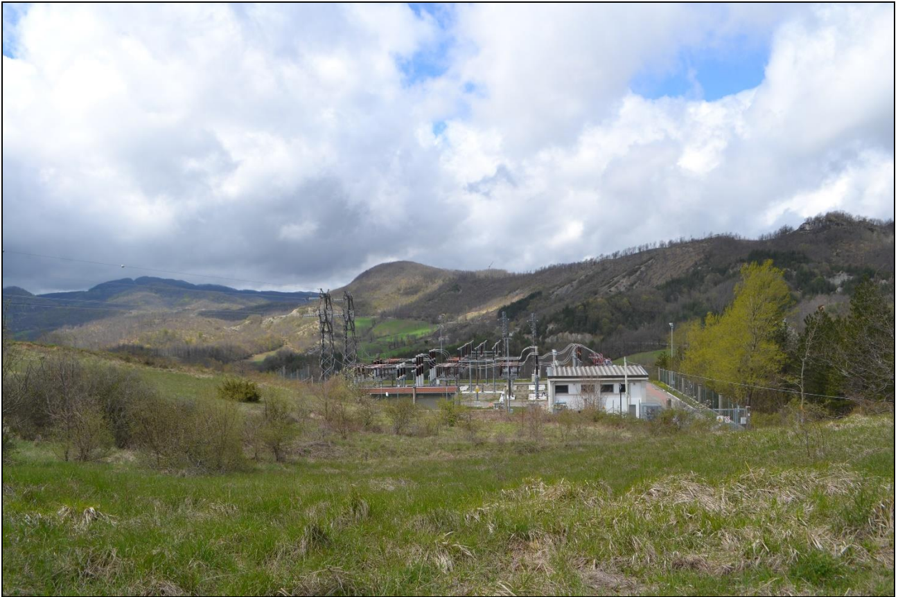
Figura 26. L'attuale sottostazione elettrica presente presso Poggio dei Prati.
