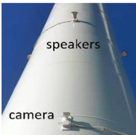
Figura 4. Sistema di monitoraggio automatico da installare sugli aerogeneratori
