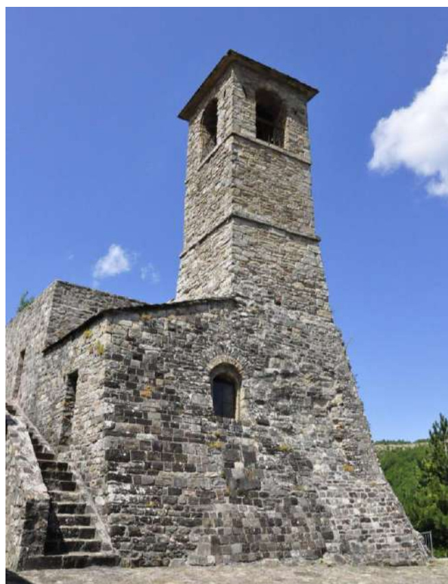
Figura 42. Torre campanaria della Chiesa di San Martino
