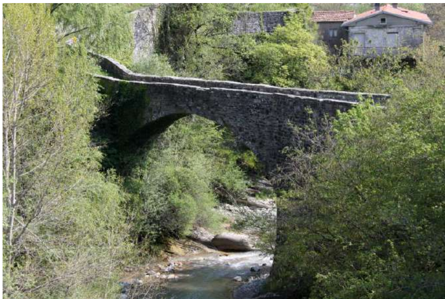
Figura 43. Ponte Vecchio Medievale – fonte Geoportale Emilia Romagna
