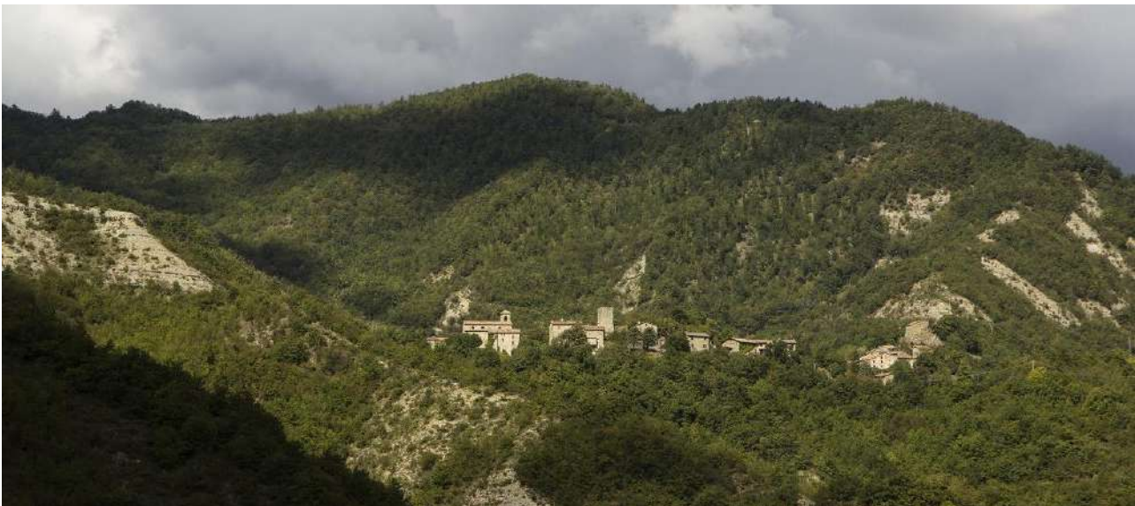
Figura 15. Vista sul borgo di Gattara, frazione di Castel delci che si pone come antica borgata in posizione dominante su di un crinale secondario, immersa in una matrice principalmente forestale
