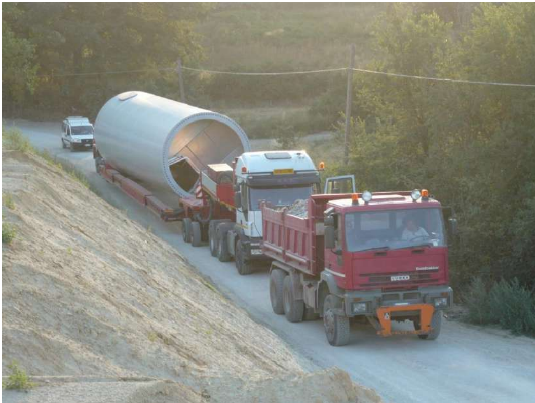
Figura 153. Trasporto tramo su viabilità di sito/cantiere con mezzi modulari
