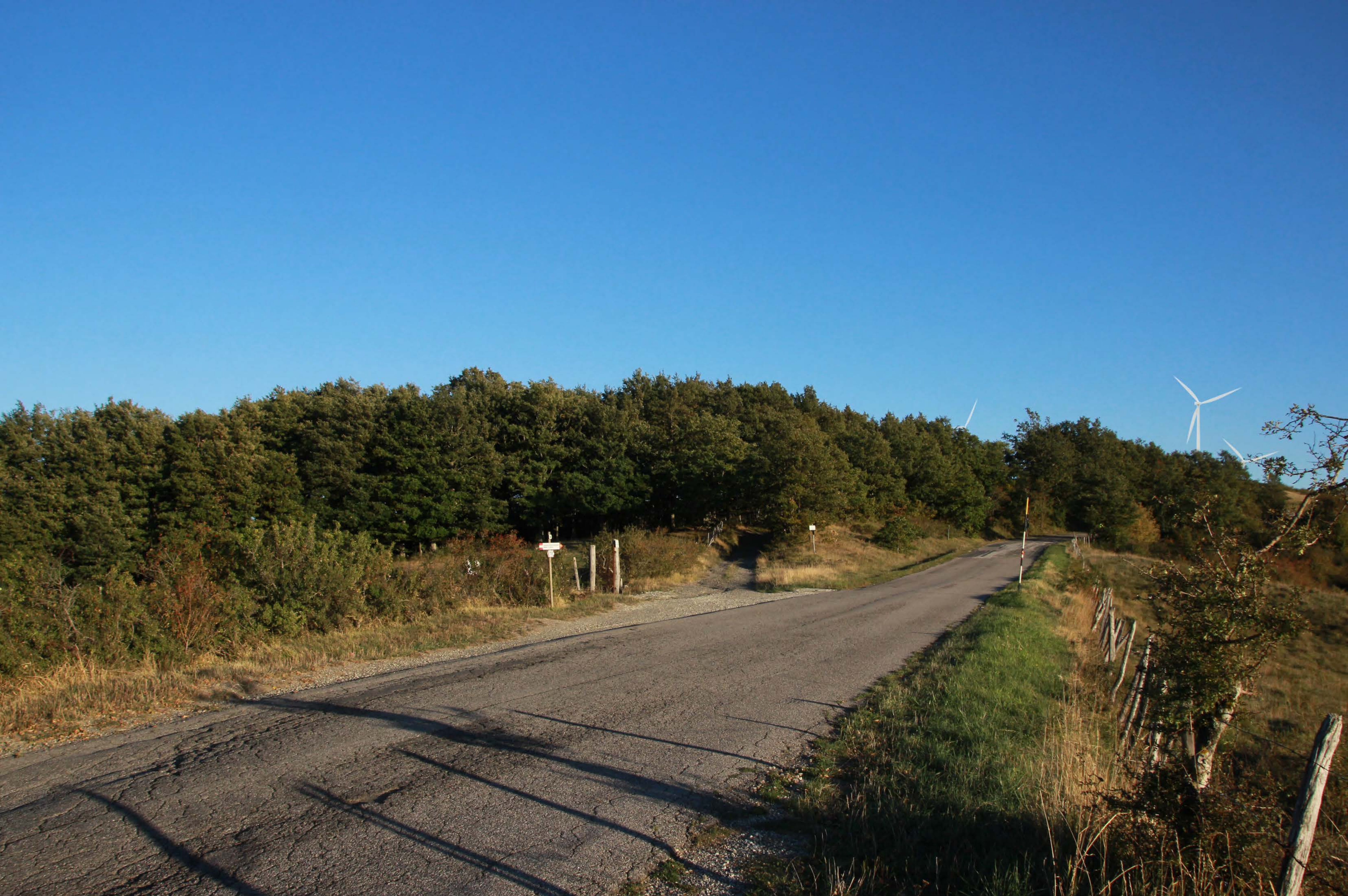
18_ SP 67 Località Torricella | post intervento
