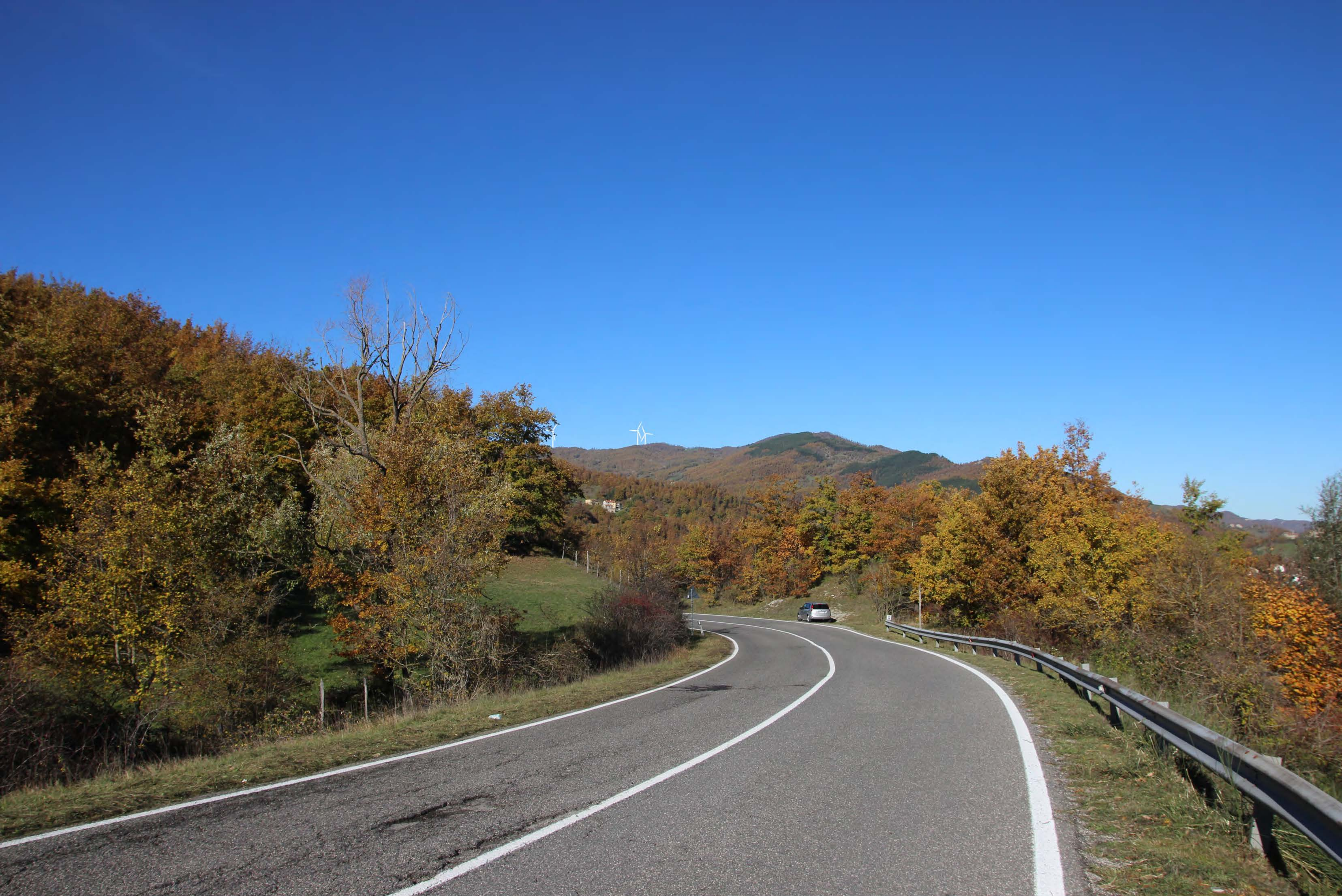
5_ SP Marecchia località Badia Tedalda | post intervento
