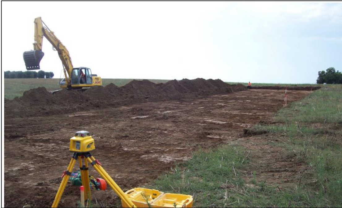
Scavo di sbancamento per la realizzazione di una nuova piazzola - si nota il terreno vegetale posizionato a bordo scavo
