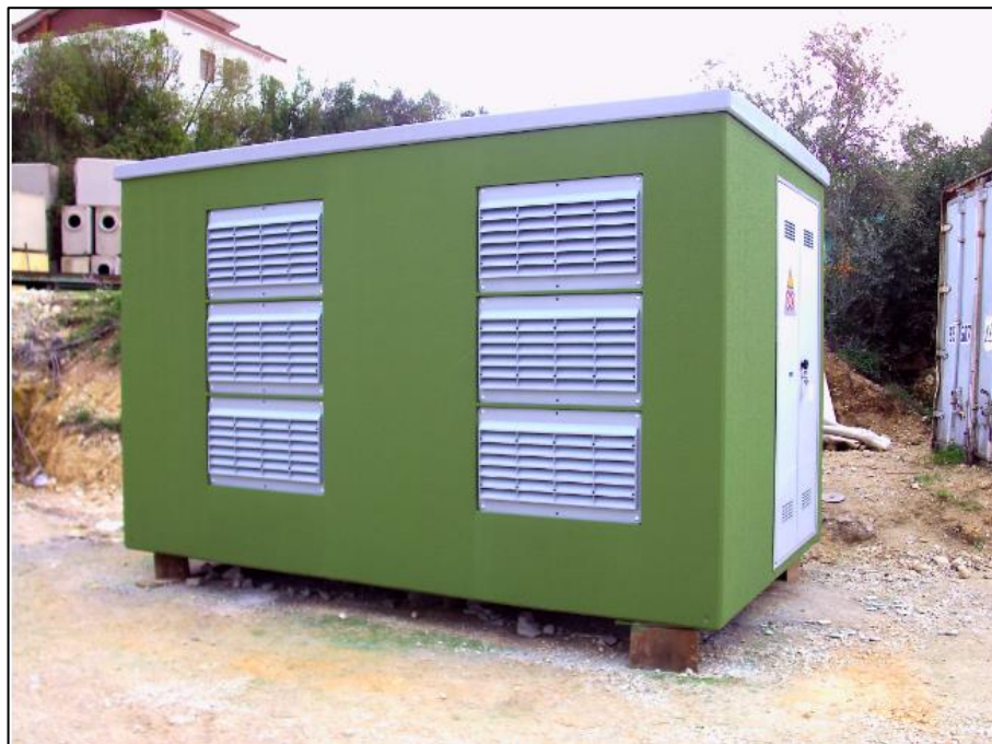
Tipico cabina elettrica prefabbricata
