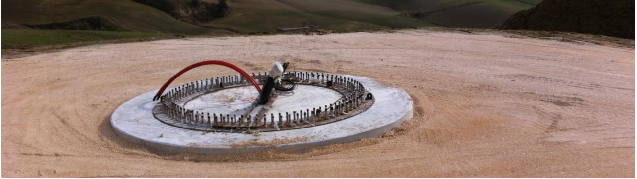
Fig. 1.8:- Tipico plinto interrato ed anchor cage
