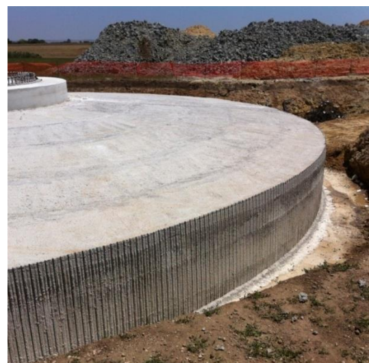
Fig. 1.7 - Tipico fondazione a plinto prima del rinterro
