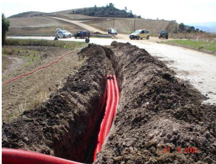
Fig. 1.11: Foto illustrativa della messa in posa dei cavidotti MT
