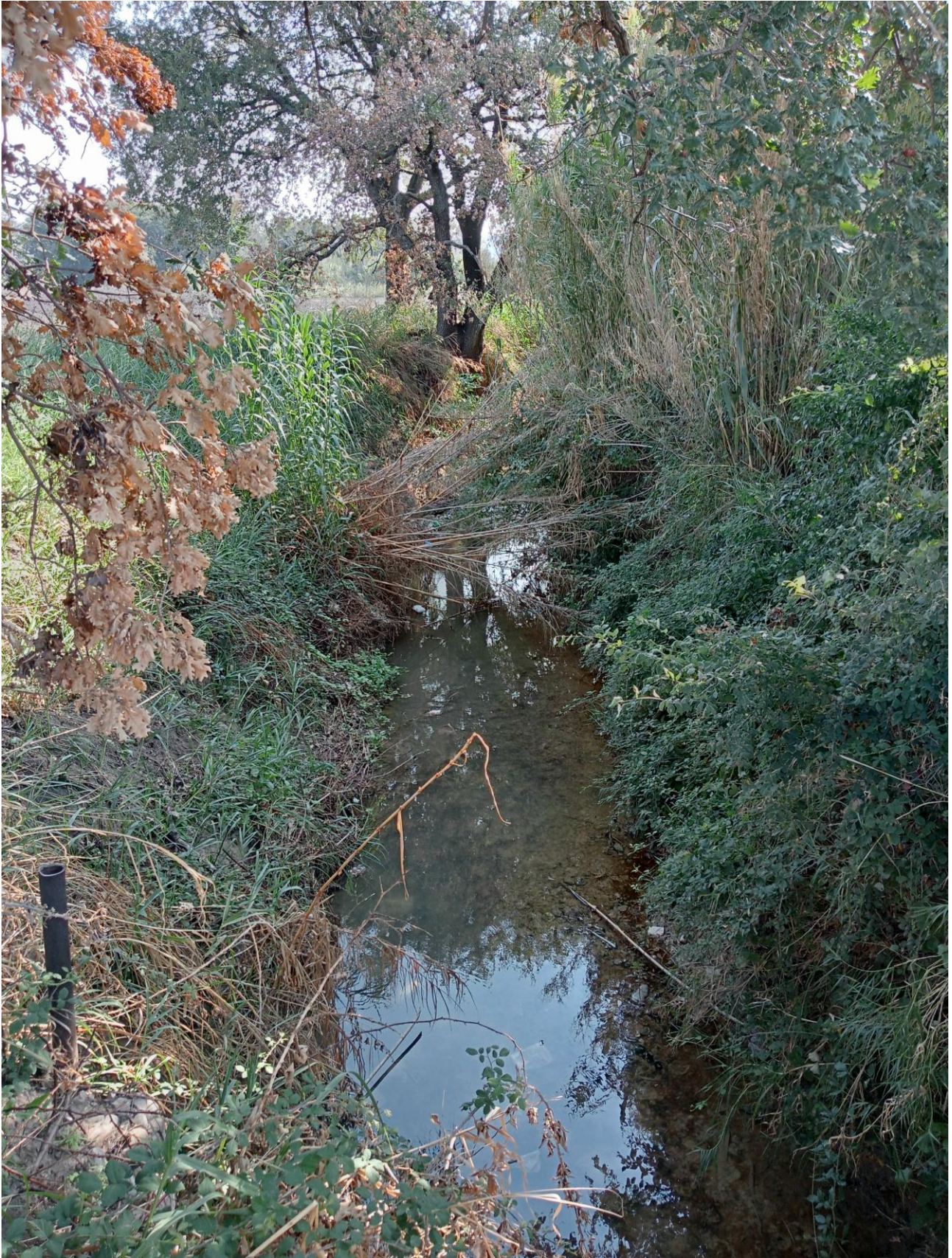
Figura 13 Canale Guado di Lucera in corrispondenza dell'attraversamento orientale del cavidotto MT
