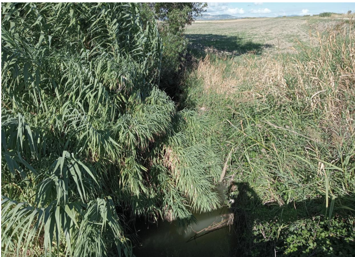
Figura 14 Canale Guado di Lucera in corrispondenza dell'attraversamento occidentale del cavidotto MT.
