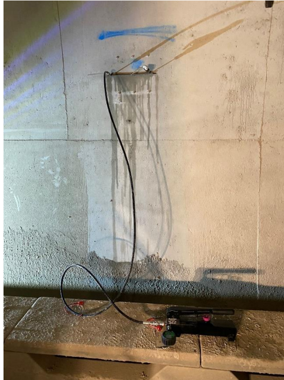
Figura 7 Martinetto in posto ed esecuzione della fase di ripristino
