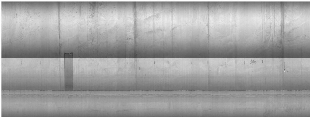
Figura 2 Esempio di immagini acquisite. La figura rappresenta la run piedritto sinistro, galleria Guinza, tra le progressive metriche di acquisizione 1150 e 1199 combinazione delle immagini acquisite dalla camera 61 (in basso) e 59 (in alto). Il segno rosso sul lato destro indica la zona sovrapposizione tra le due immagini.
