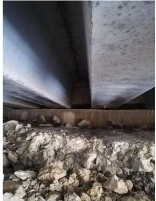
Figura 7-8 – Travetto deteriorato e Dettaglio appoggio travi.
