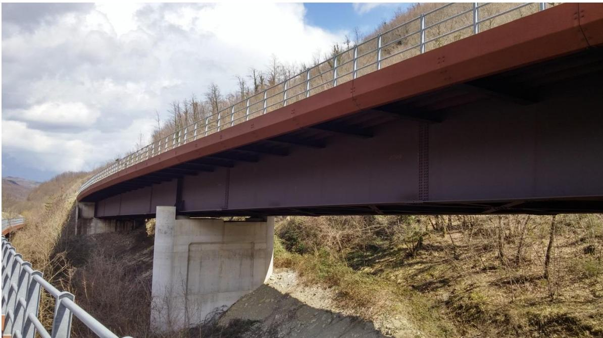
Figura 18 - impalcati sfalsati costituenti il Viadotto Sorgente
