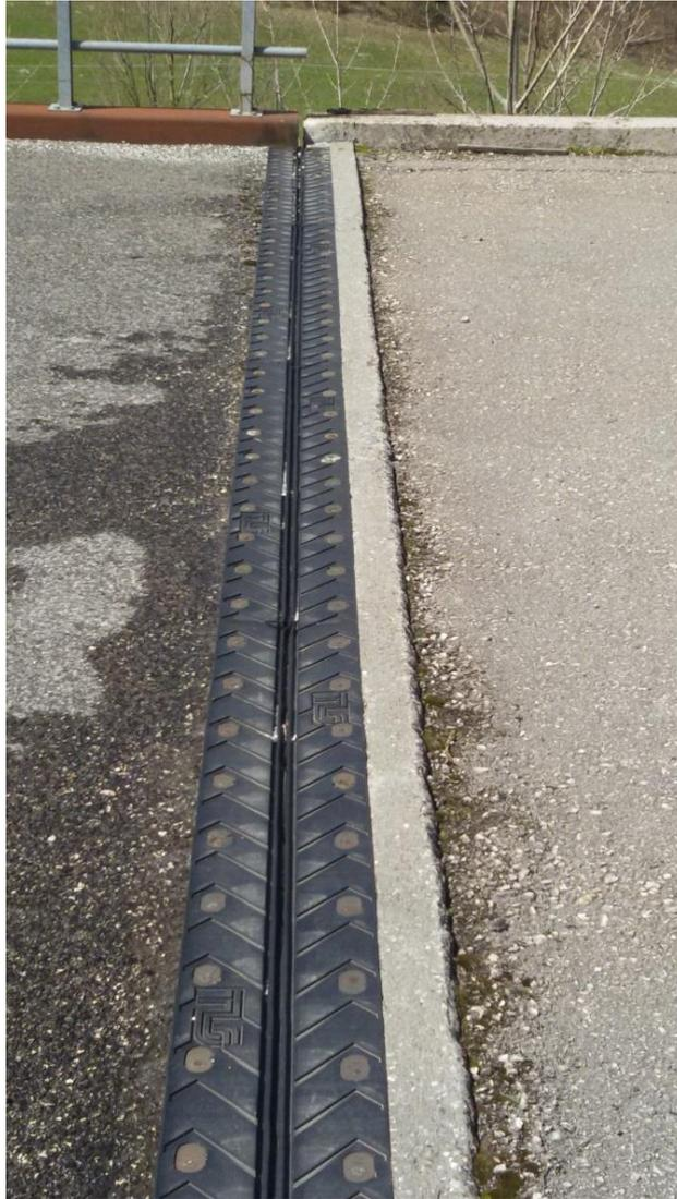
Foto 23 – Dettaglio giunto viadotto sorgente
