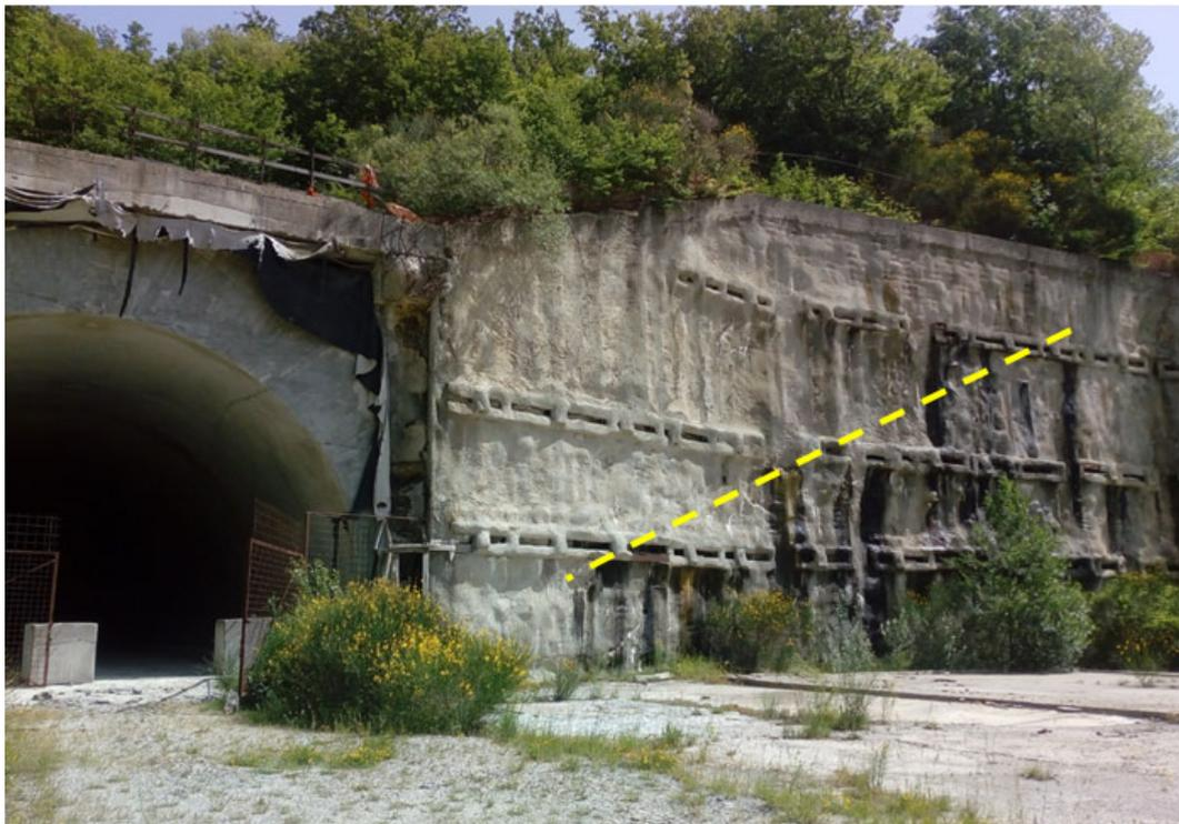
**Figura 31:** Imbocco della galleria Guinza lato Umbria, con la paratia di micropali tirantati attraverso cui è visibile l'afflusso idrico permanente (o semi-permanente). A meno del "disturbo idrogeologico" ed effetto drenante indotto dagli scavi e dalle fessurazioni secondarie, i punti di afflusso sembrano allineati all'incirca lungo l'immersione (linea gialla tratteggiata, componente lungo la paratia) della stratificazione della Marnoso-Arenacea.
