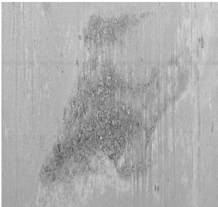
Figura 9: Esempio di vespai - Galleria Guinza – p.k. 0+720 circa
