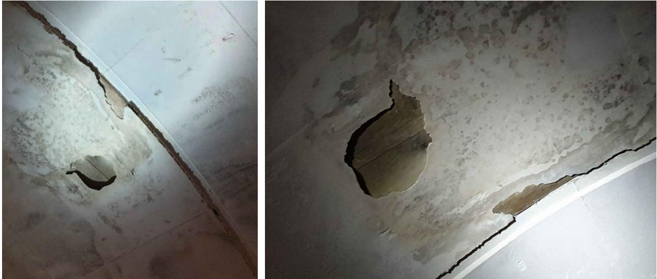
Figura 11: Impermeabilizzazione a vista - Galleria Guinza – p.k. 5+636 circa
