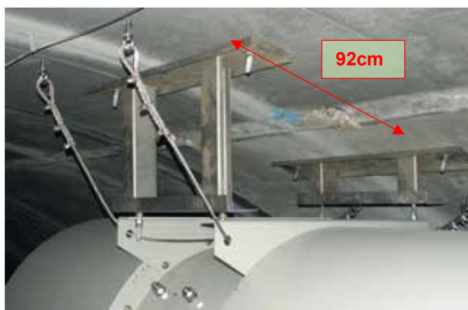
Figura 8: Esempio ancoraggio ventilatori al rivestimento definitivo
