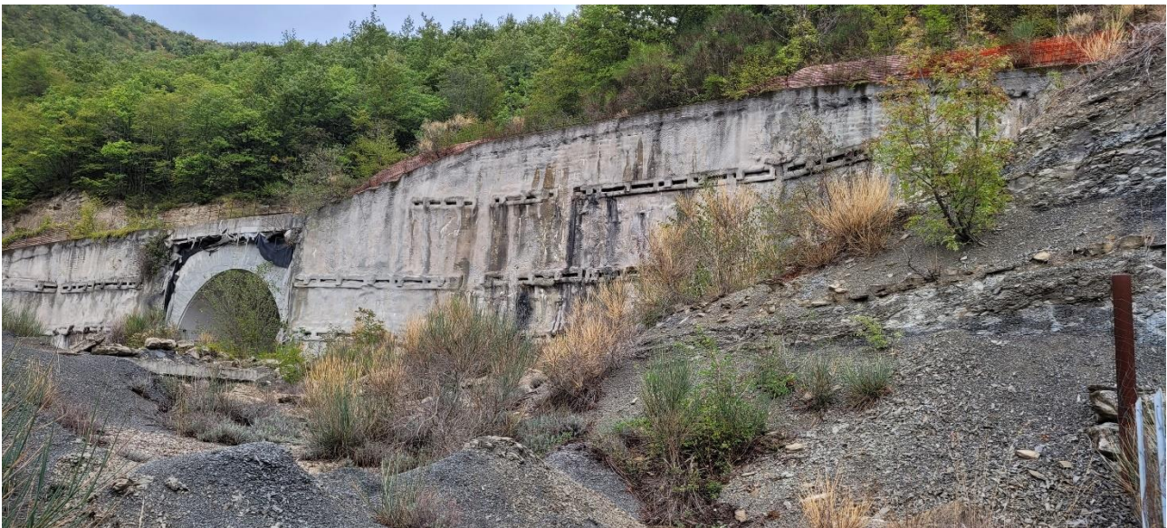
Figura 2 – Paratia esistente – immagine stato di fatto
