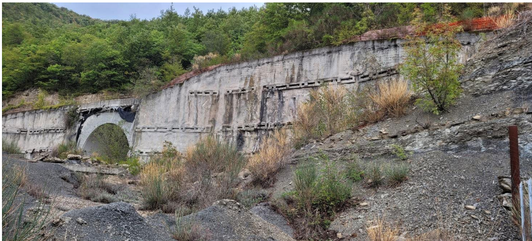
Figura 29 – Galleria Guinza- Imbocco lato Umbria - Paratia esistente – Stato di fatto
