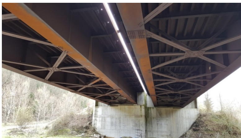
Figura 62 - Vista dal basso del viadotto La Pieruccia
