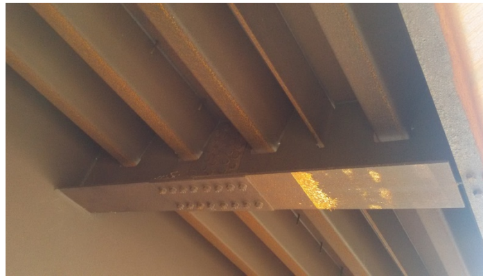
Figura 60 – Cordolo del viadotto metallico
