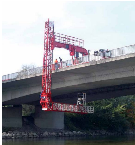
Figura 55 - Piattaforma aerea sottoponte
