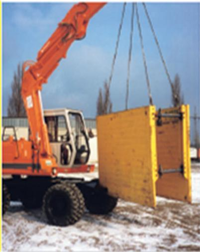
Il box di blindaggio già montato viene posato nello scavo finito.
