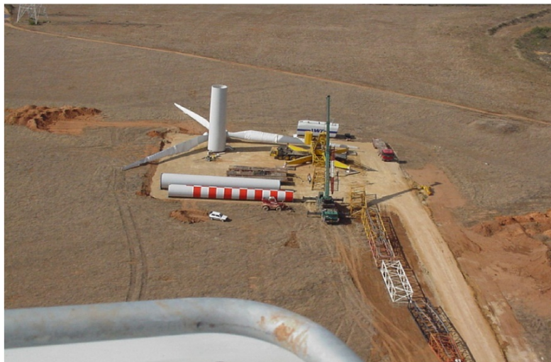
Figura 2 – Piazzola per il montaggio dell'aerogeneratore
