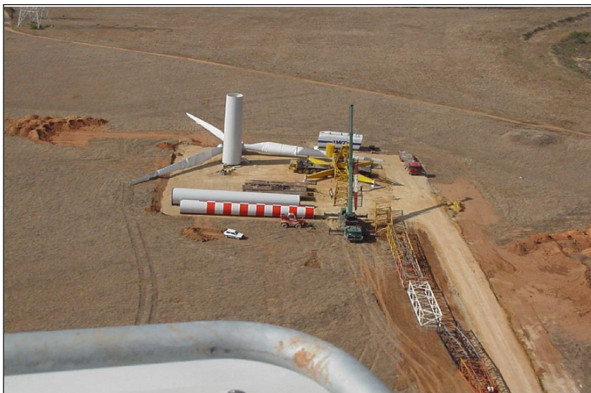
Foto 1. Piazzola per il montaggio dell'aerogeneratore
