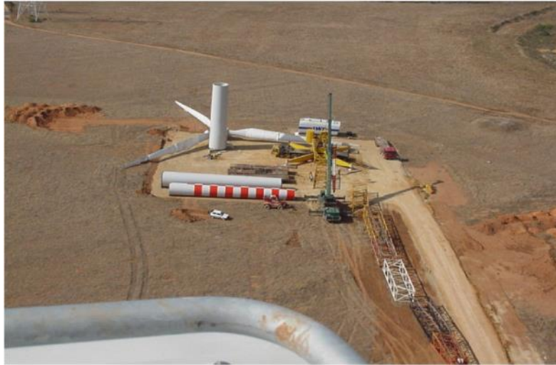
Figura 35 – Piazzola per il montaggio dell'aerogeneratore
