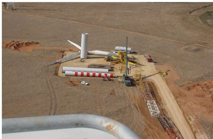
Figura 11 – Piazzola per il montaggio dell'aerogeneratore
