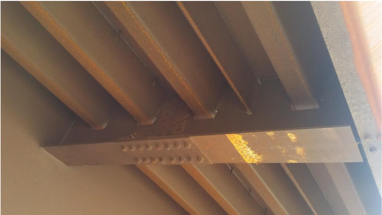
Figura 52 – Cordolo del viadotto metallico
