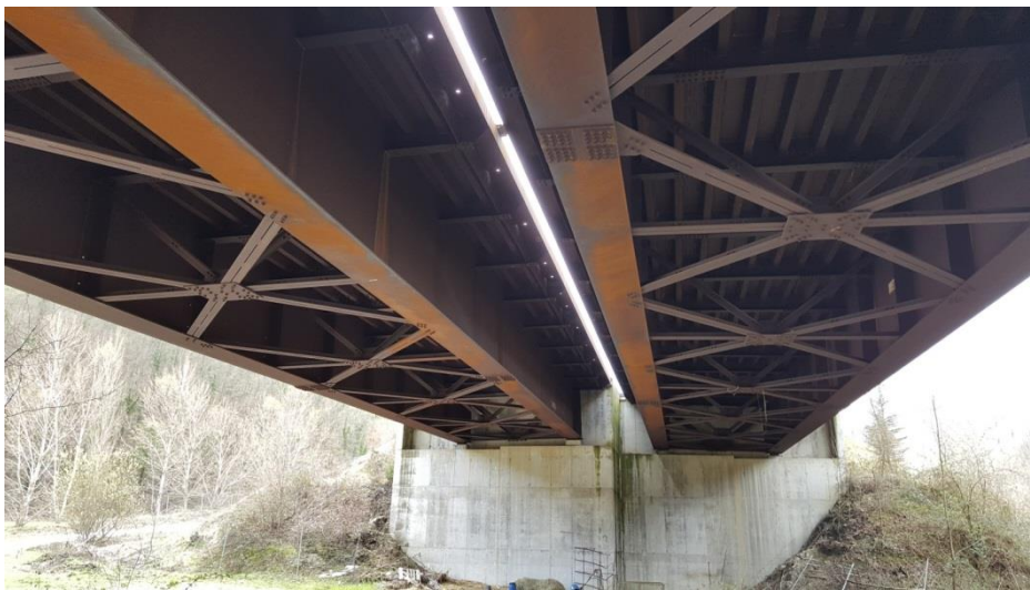
Figura 54 - Vista dal basso del viadotto La Pieruccia
