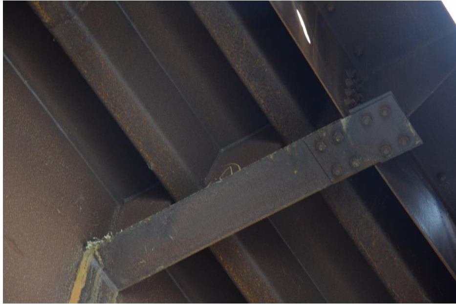
Figura 55 - Particolare del cordolo
