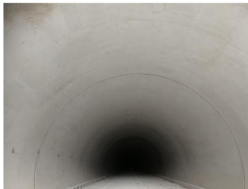
Figura 21 – Rivestimento definitivo galleria Guinza
