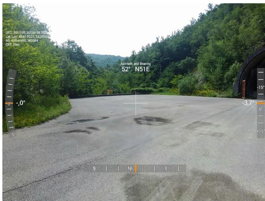
Figura 9 – Ponte Guinza all'uscita della galleria sul versante marchigiano
