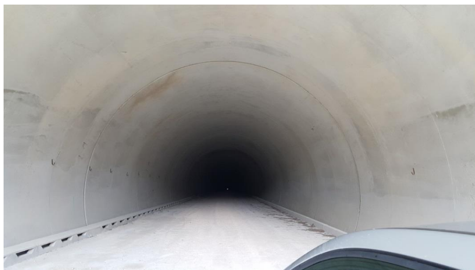
Figura 8 – Interno della Galleria della Guinza
