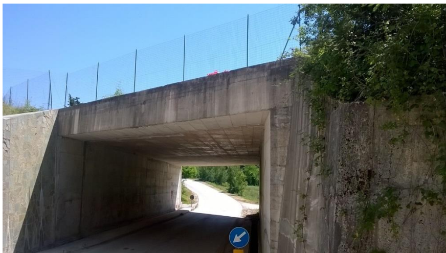
Figura 10 – Sottovia scatolare comunale
