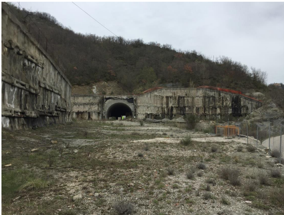
Figura 7 – Imbocco della Guinza lato Parnacciano – Stato di fatto
