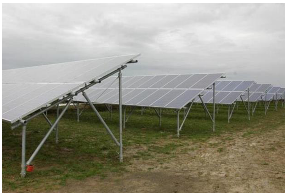
Figura 16: Esempio impianto a strutture fisse
