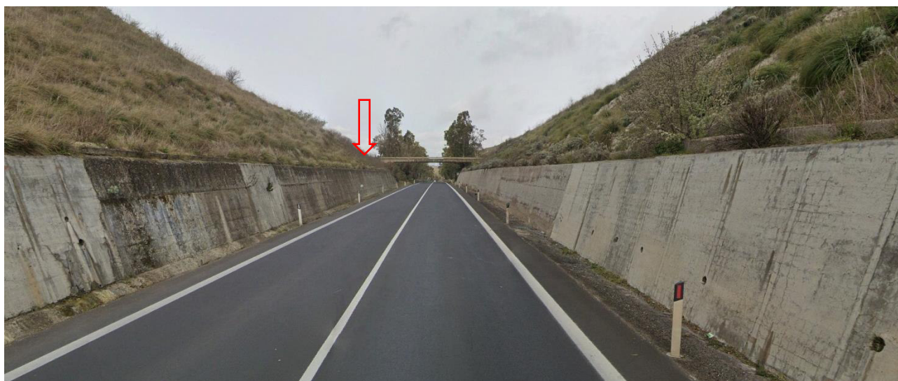
Figura 42: Punto di vista n. 5_ Strada SS514: in rosso indicata la direzione dell'area di progetto.
