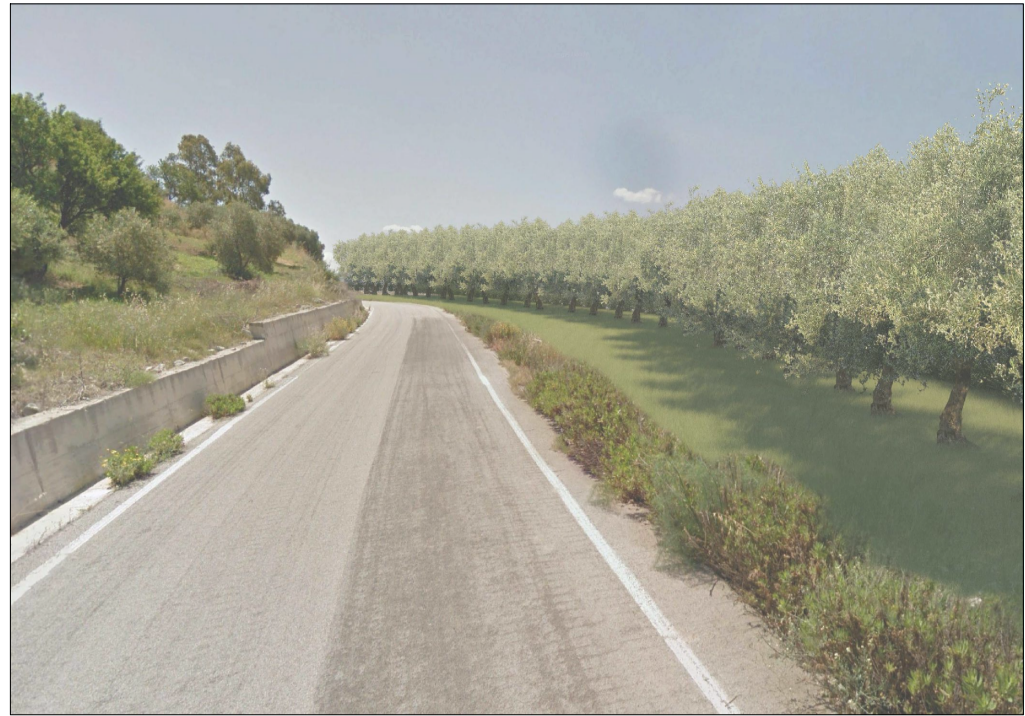
STATO POST OPERAM - VISTA 11
