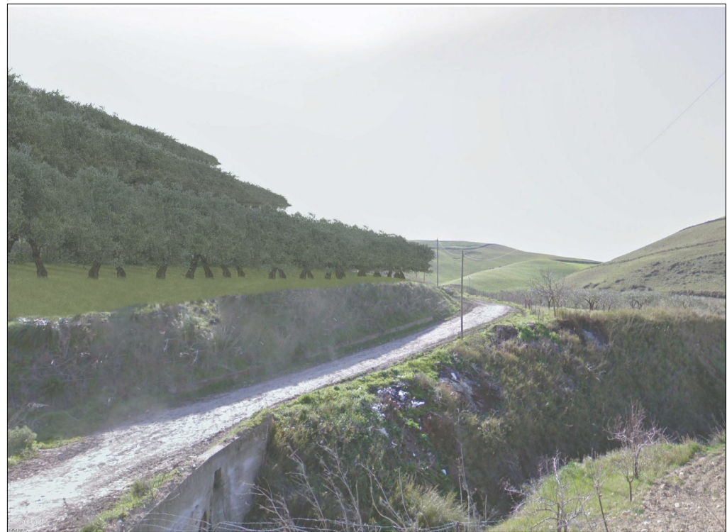
STATO POST OPERAM - VISTA 15
