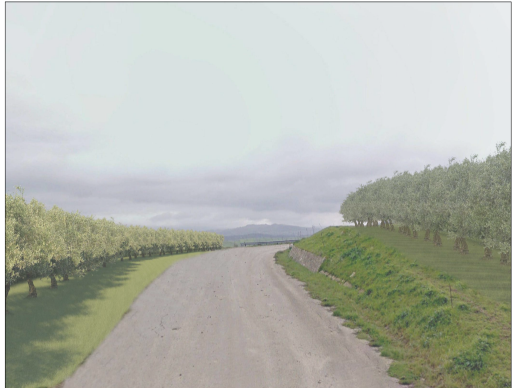
STATO POST OPERAM - VISTA 13
