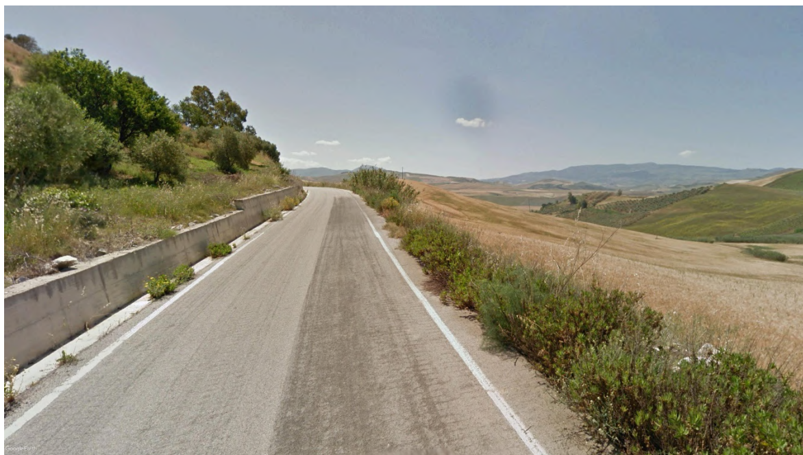
Vista 11- Stato ante-operam
