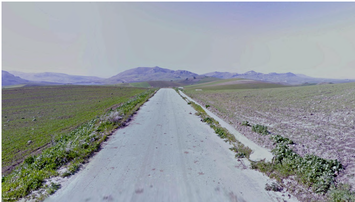
Vista 10- Stato ante-operam
