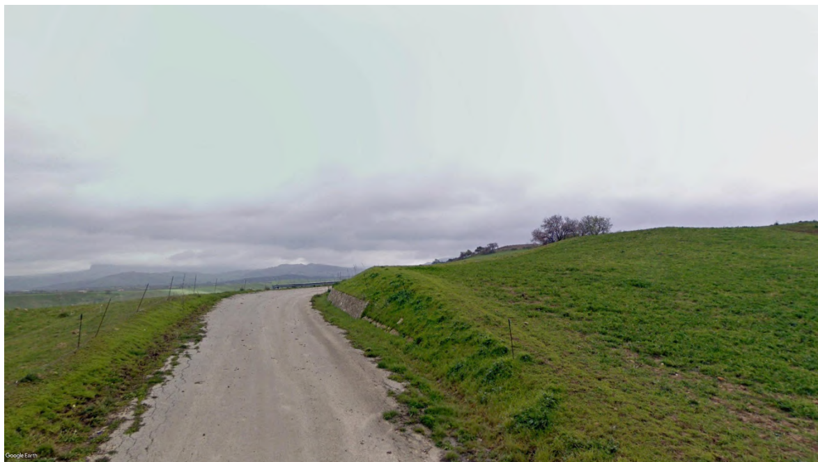
Vista 13- Stato ante-operam
