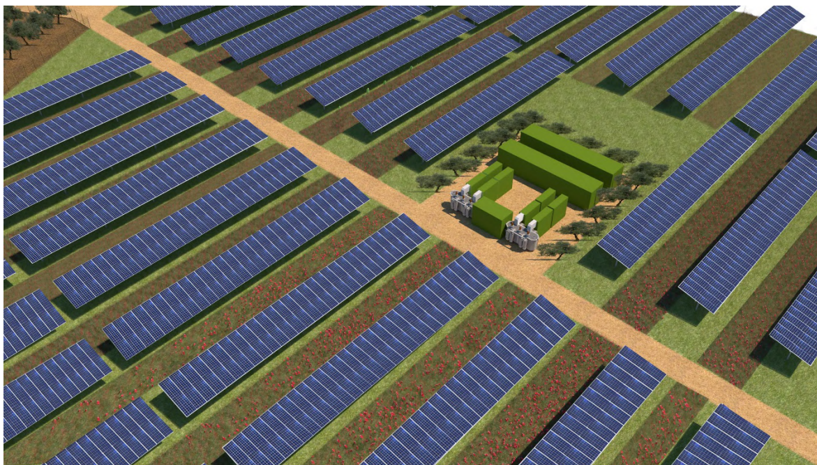
Fig. 5 - Vista cabine dal basso
