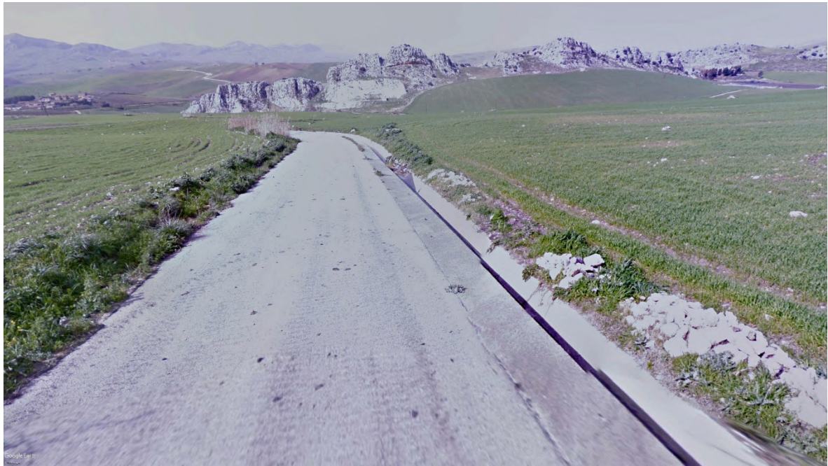
Vista 7- Stato ante-operam
