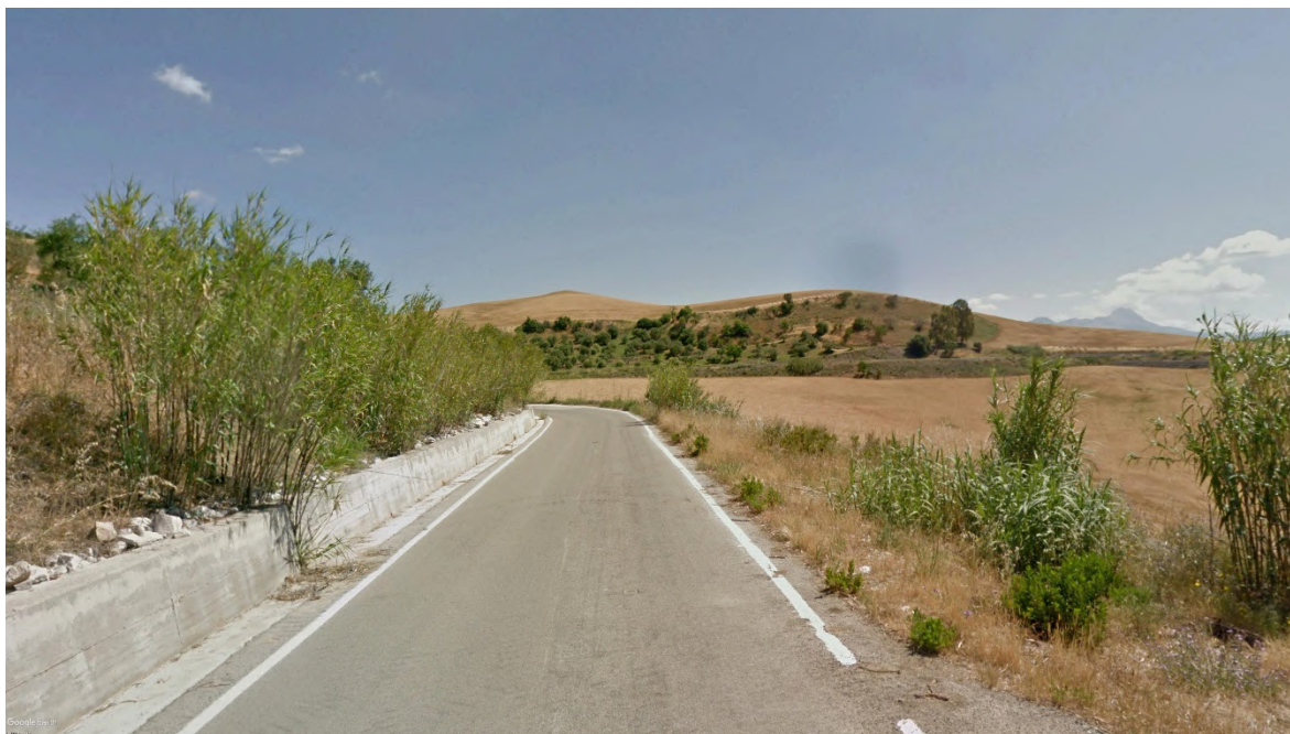
Vista 12- Stato ante-operam
