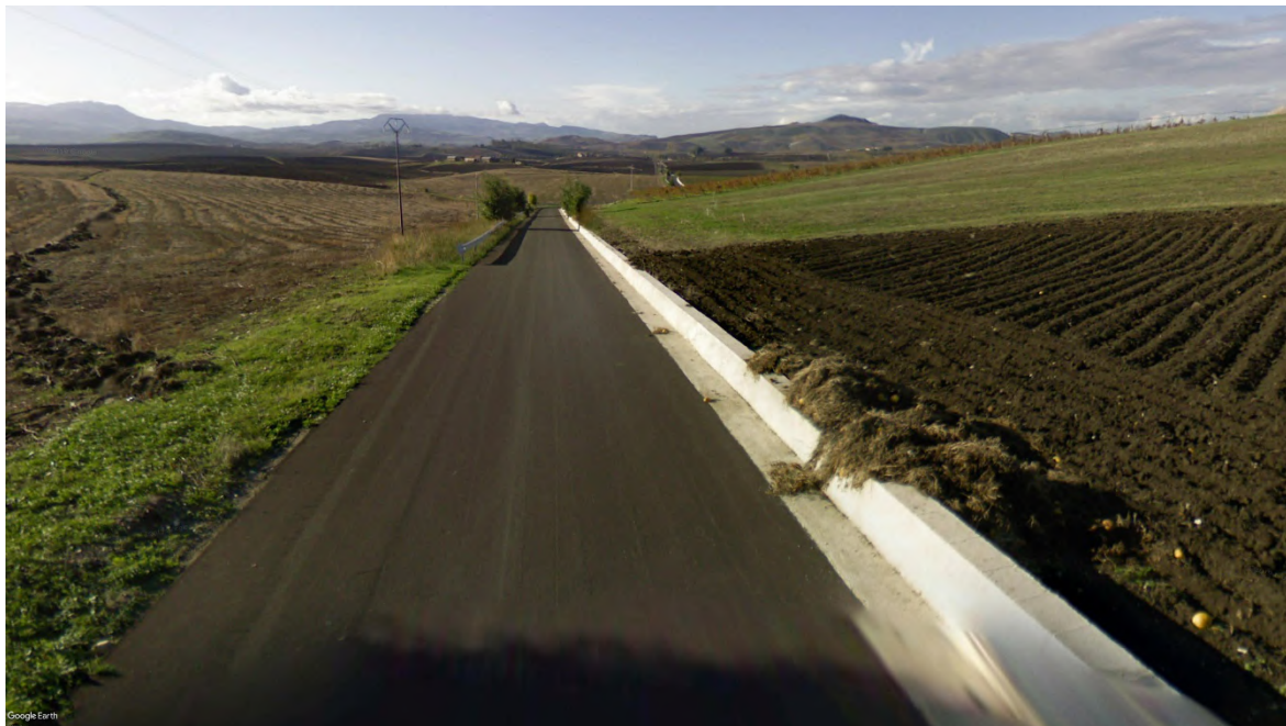
Vista 1- Stato ante-operam
