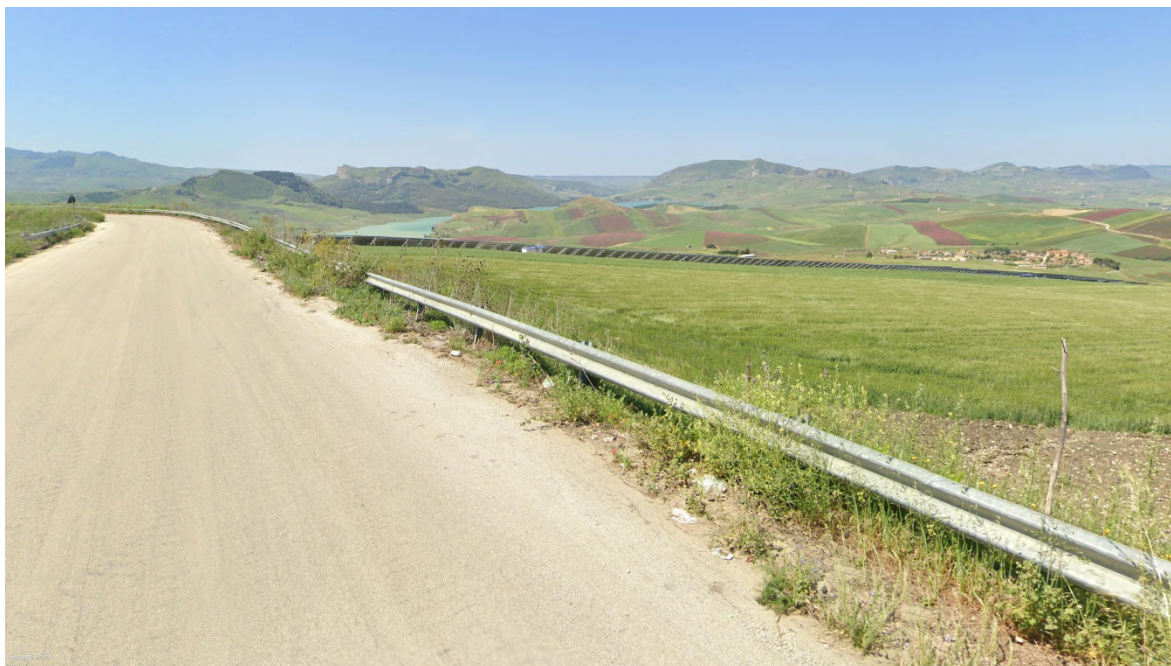
Vista 8- Stato ante-operam
