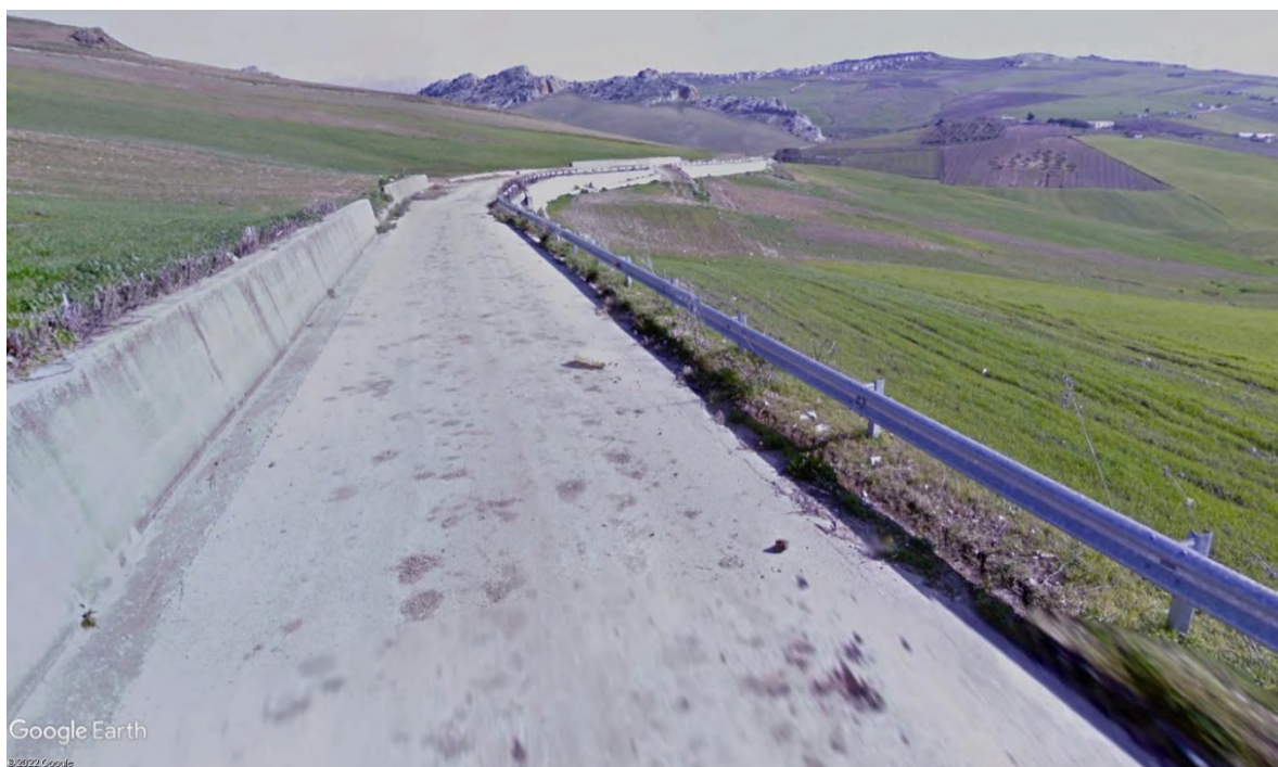
Vista 9- Stato ante-operam
