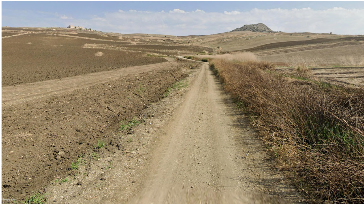
Vista 5- Stato ante-operam
