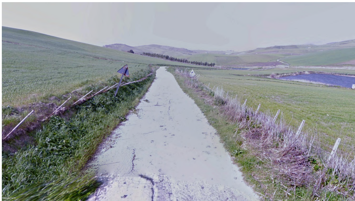
Vista 4- Stato ante-operam
