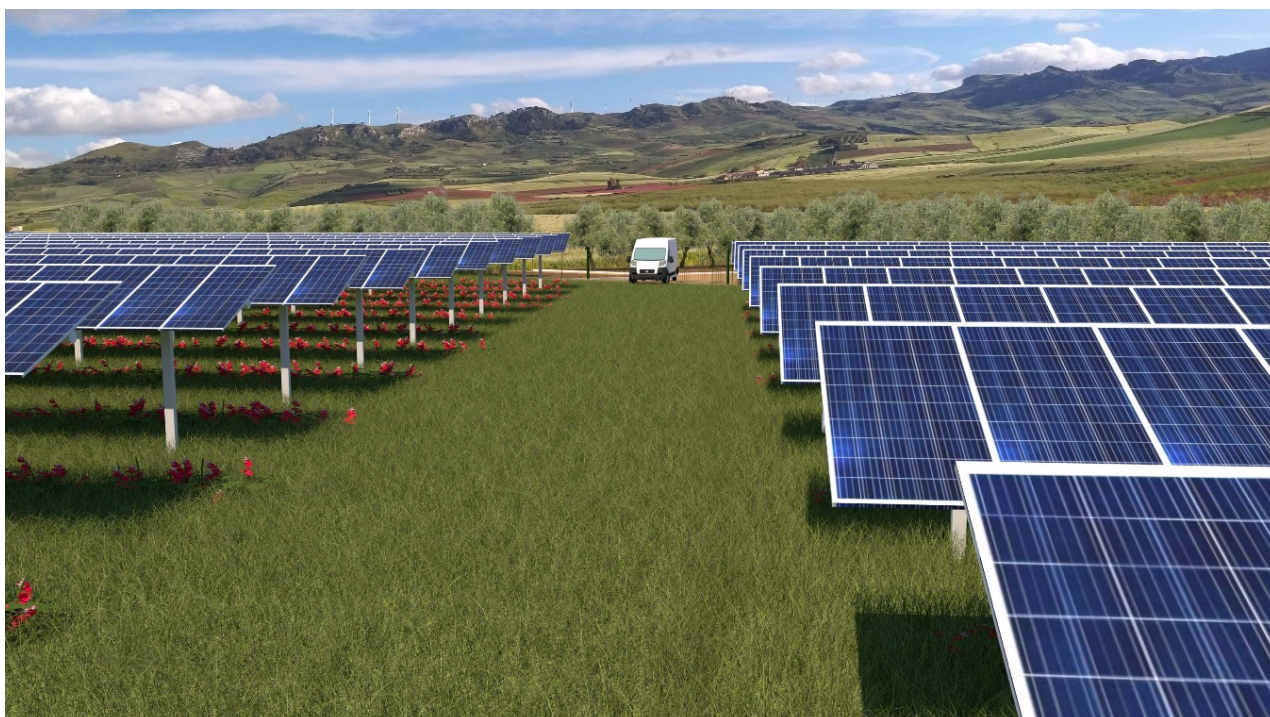
Fig. 11 - Vista centrale dal basso
