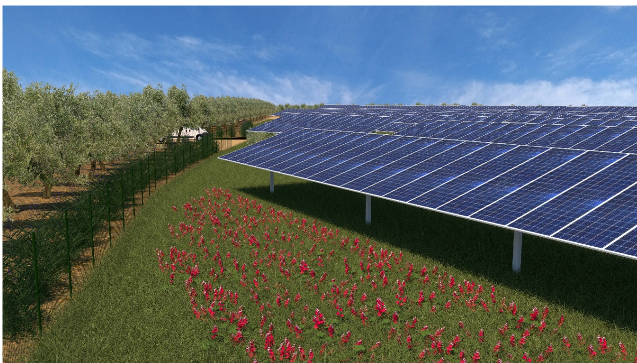
Fig. 13 - Vista perimetrale dall'interno dell'impianto
