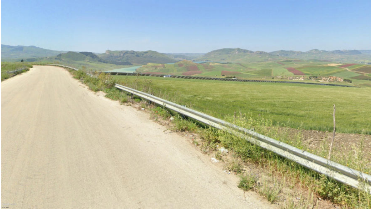
Vista 8 – Stato ante-operam
