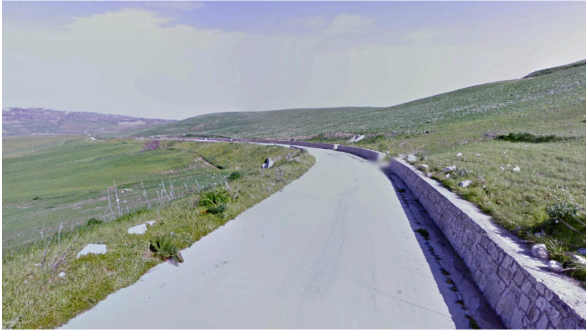
Vista 14 – Stato ante-operam
