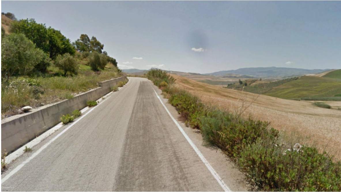
Vista 11 – Stato ante-operam
