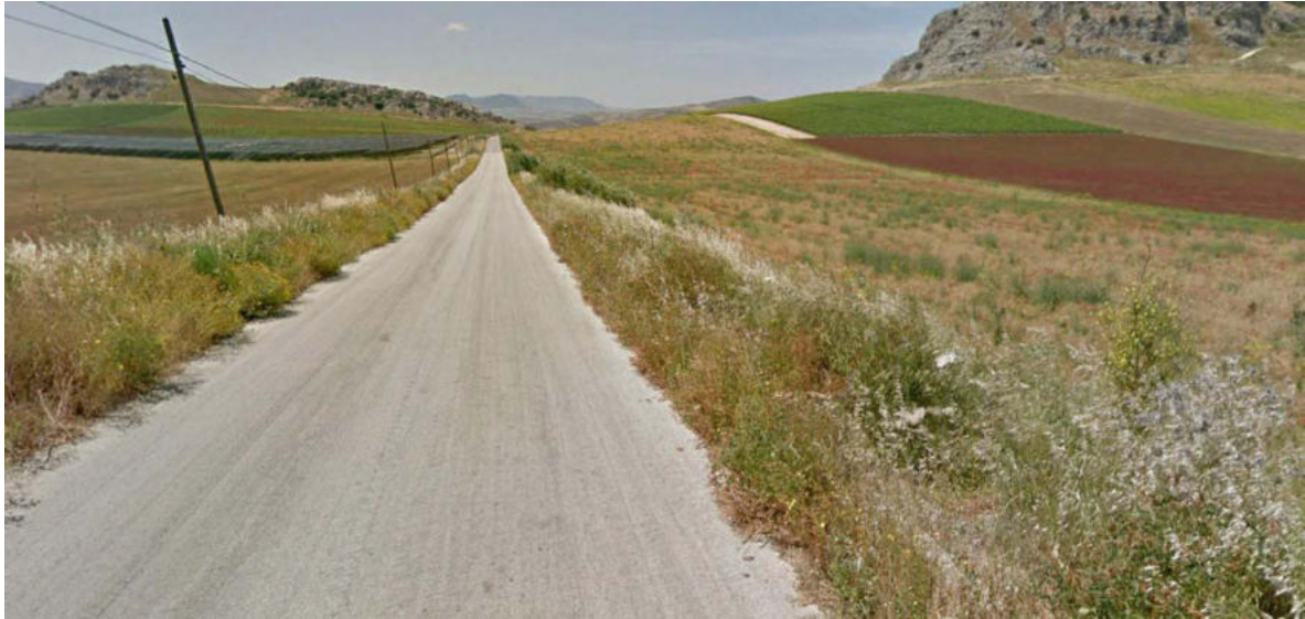
Vista 6 – Stato ante-operam
