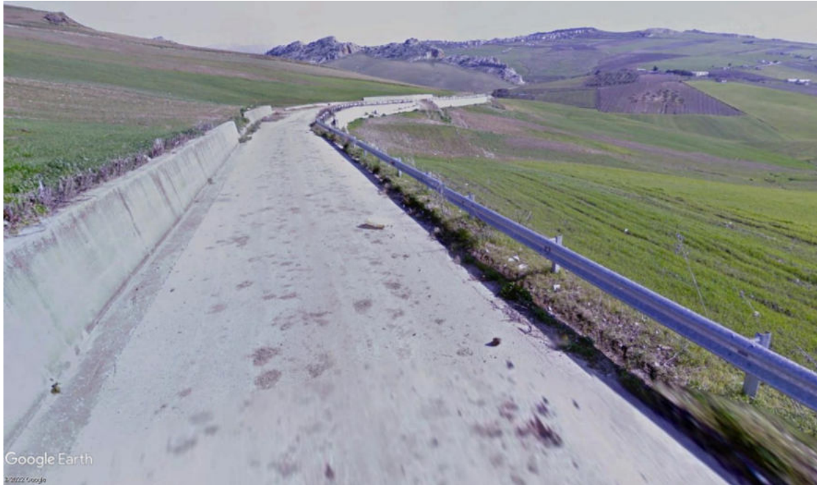
Vista 9 – Stato ante-operam
