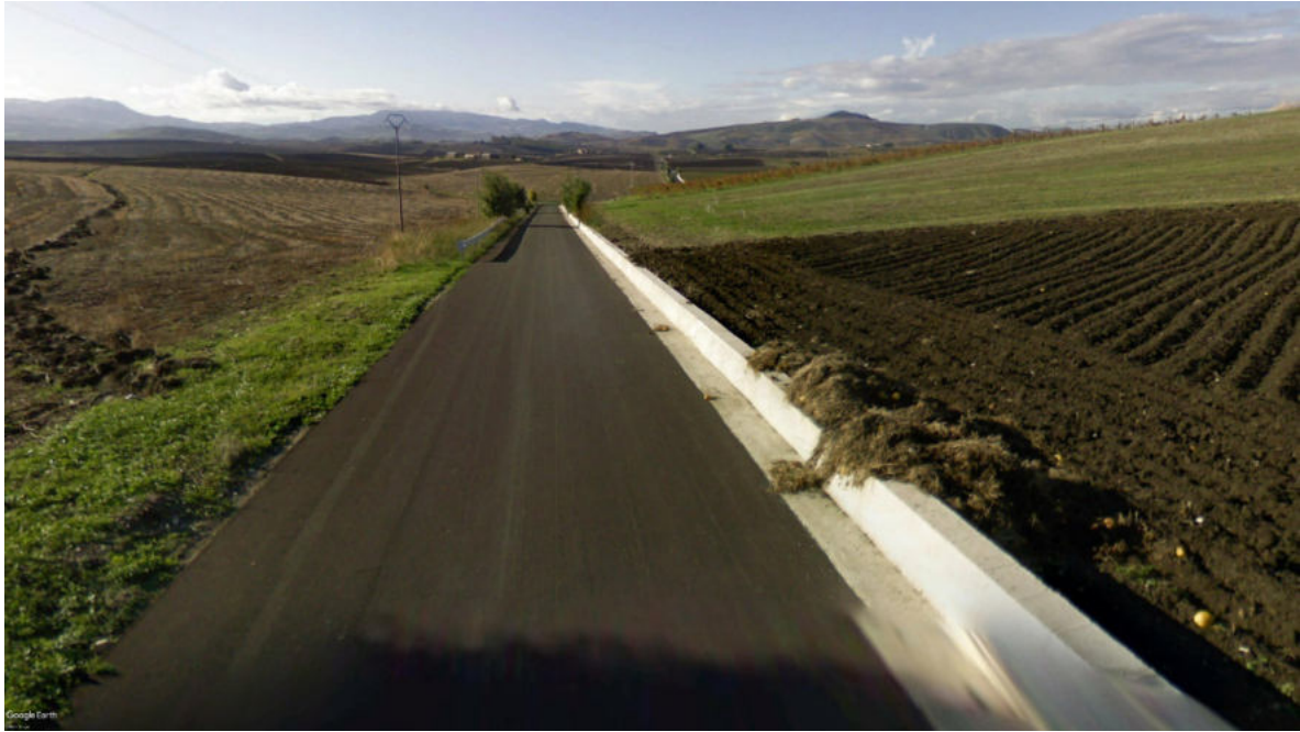
Vista 1 – Stato ante-operam
