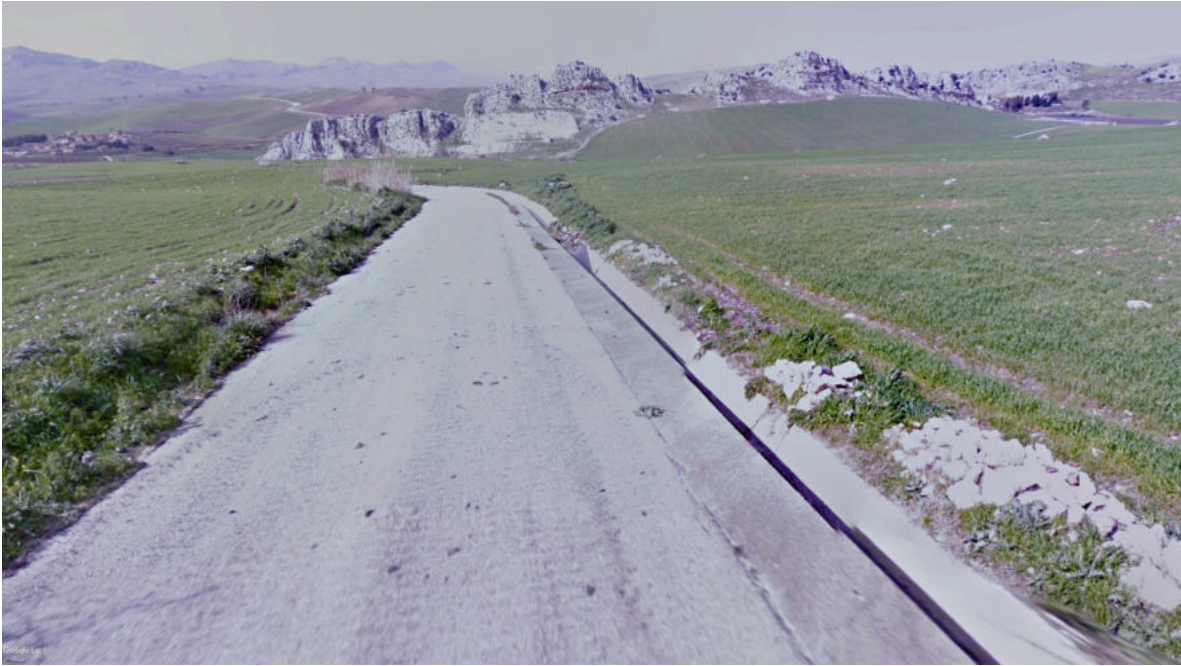
Vista 7 – Stato ante-operam
