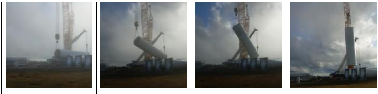
Figura 5.34 – Schema delle fasi di sollevamento dei componenti dell'aerogeneratore (Fonte sito web http://www.windfarmbop.com/ )
