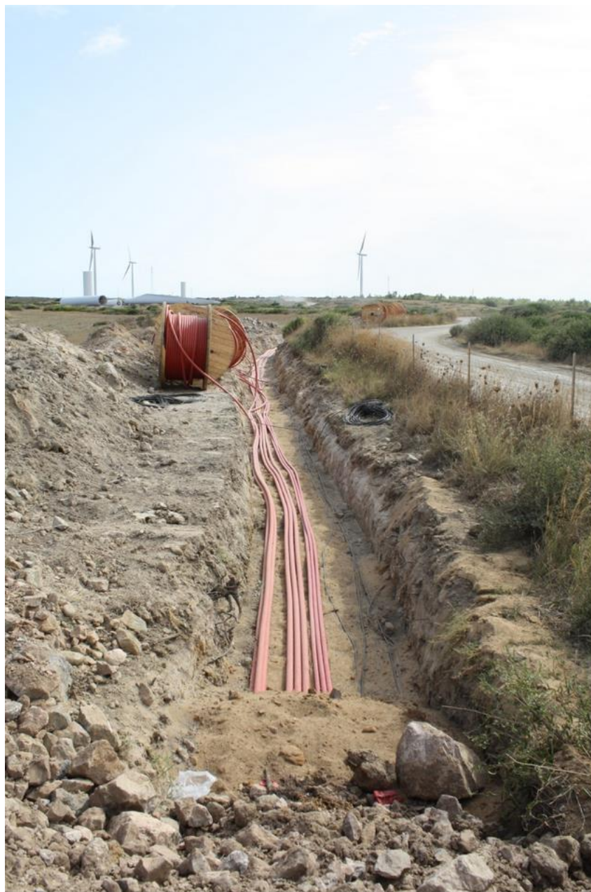
Figura 6.6 - Tipico scavo e linee MT interrato
