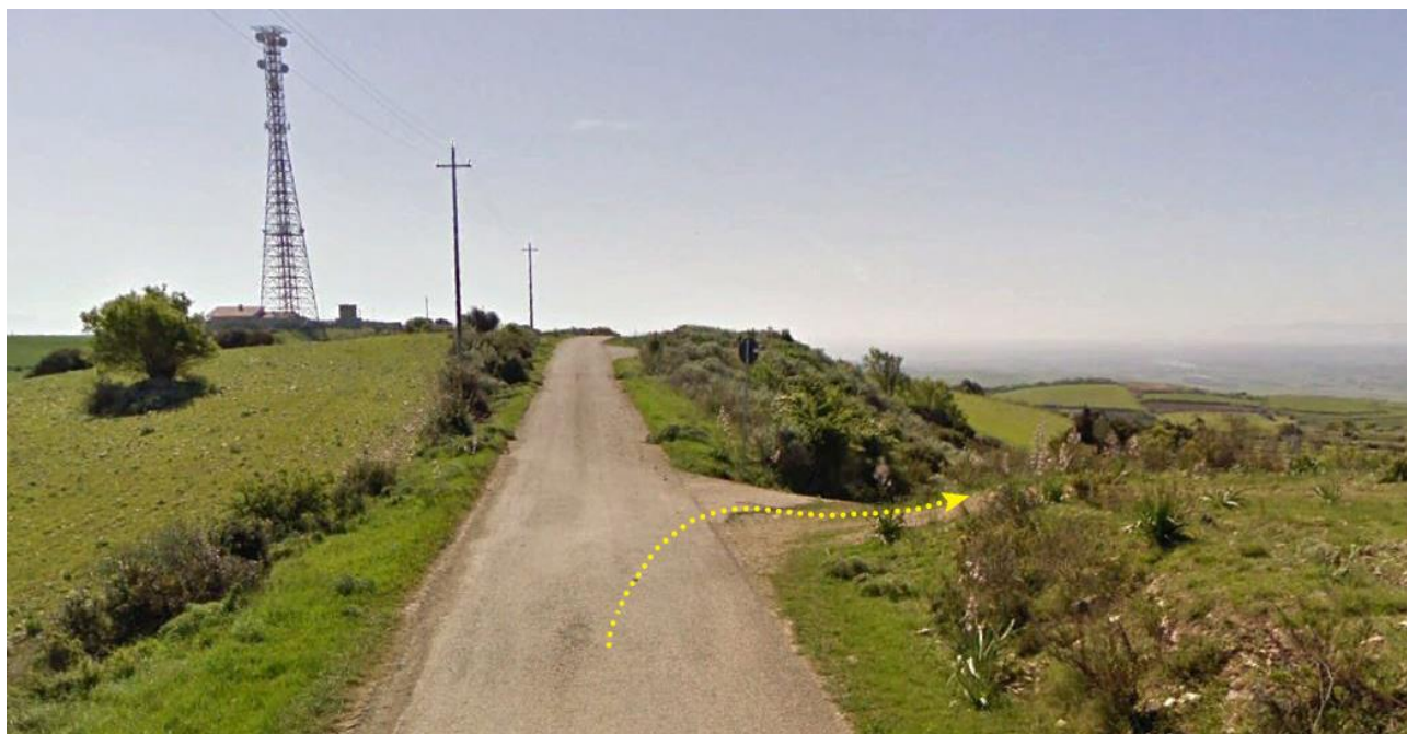
Figura 5.5 - Punto di accesso alle postazioni eoliche SR02 e SR01 (direzione sud-est)
