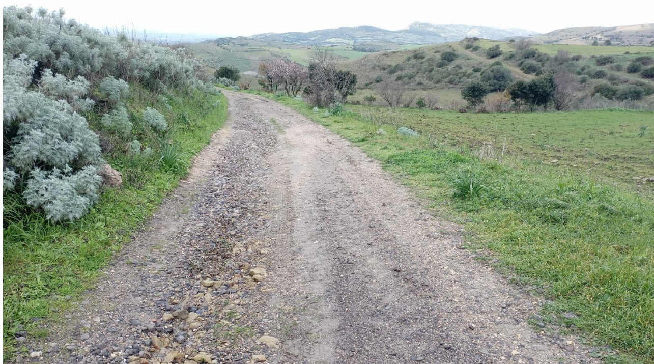
Figura 5.3 - Strada campestre da utilizzare per l'accesso alle postazioni eoliche SR02 e SR01 (direzione sud-est)
