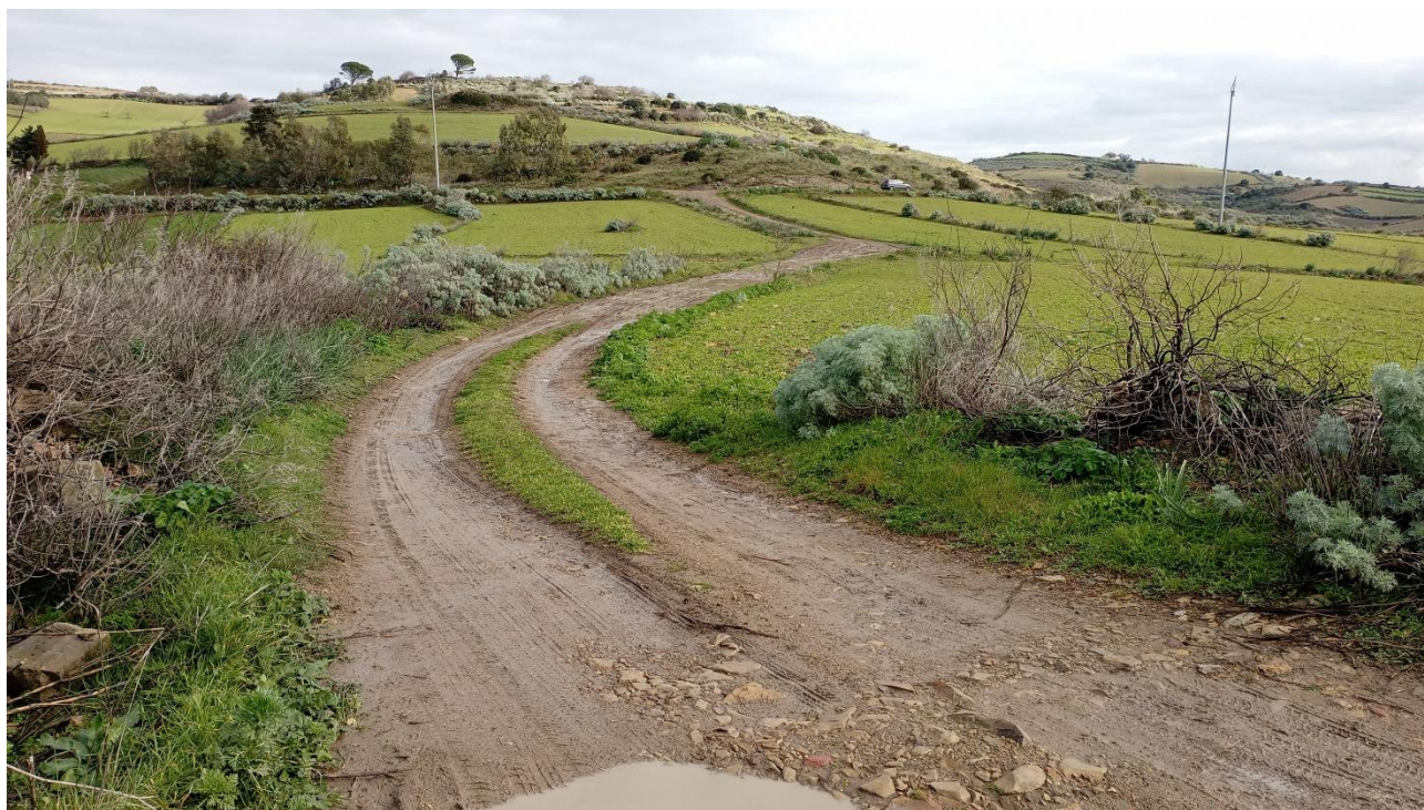
Figura 5.12 – Tratturo di viabilità esistente di accesso alla postazione eolica SR04 facente parte della viabilità di progetto (vista verso sud)
