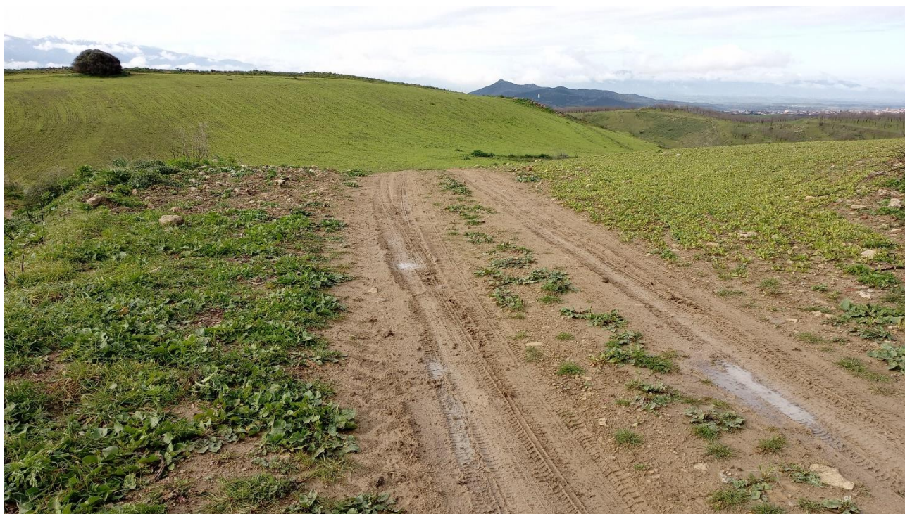
Figura 5.14 – Tracciato della viabilità esistente di collegamento alla postazione eolica SR03 (vista verso sud-ovest)
