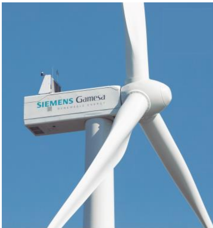
Figura 4.1 – Aerogeneratore Siemens-Gamesa 6.2-170 da 6.2 MW
