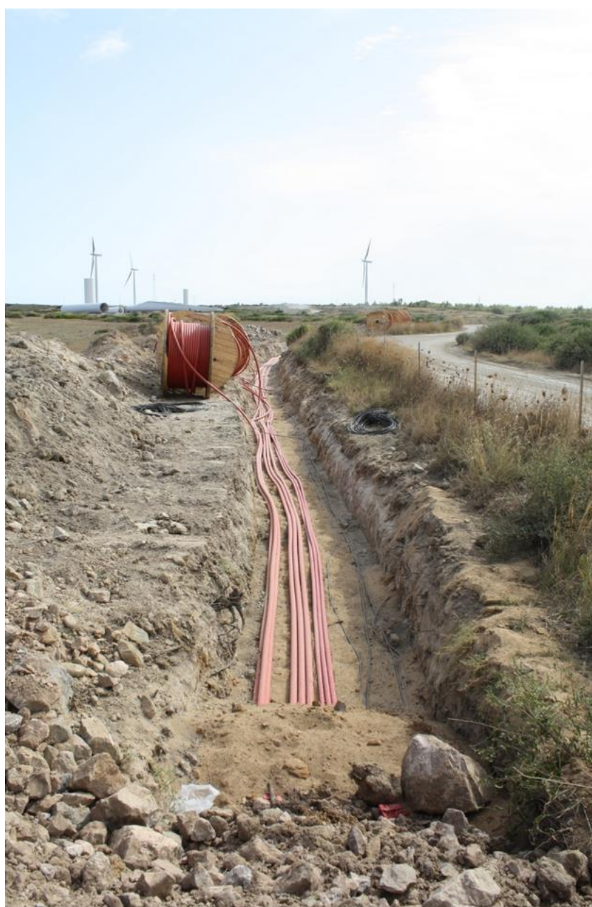
Figura 3.6 - Tipico scavo e linee MT interrato
