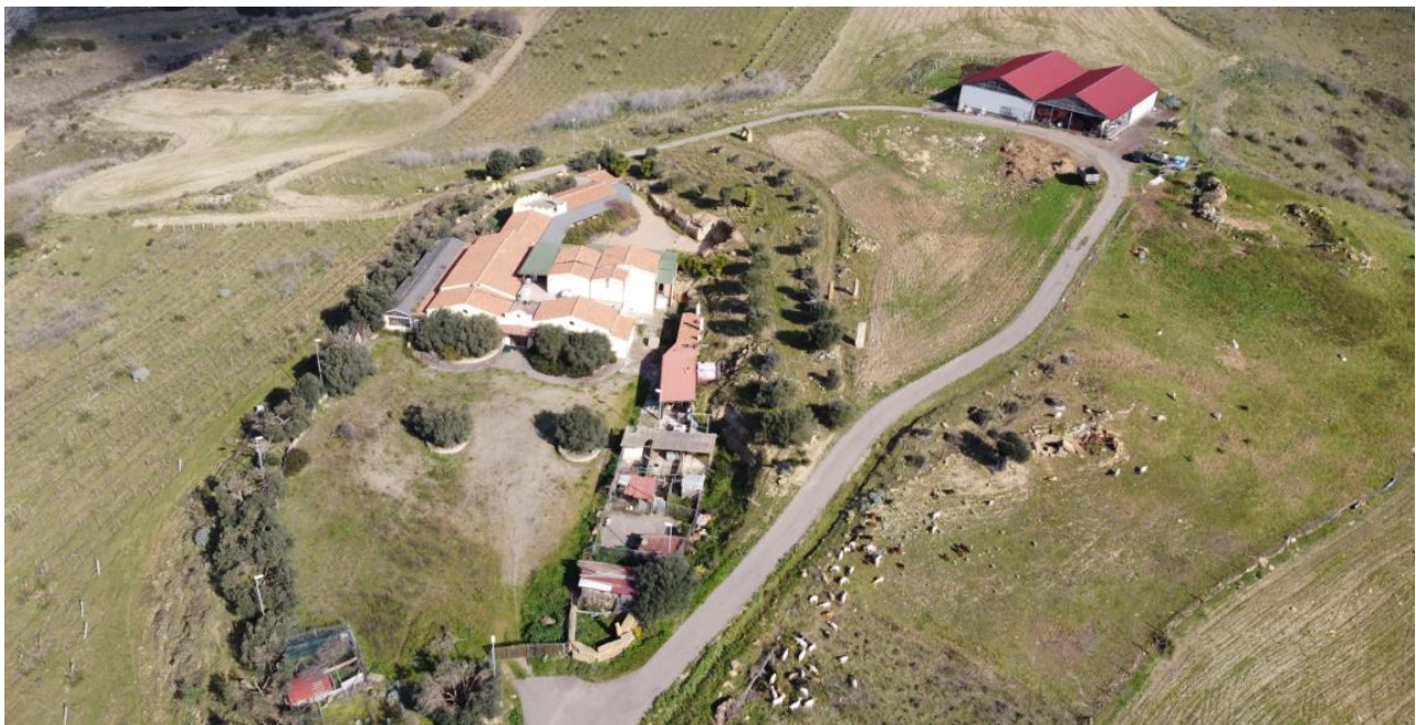
Figura 6.4 – Struttura agrituristica con identificativo F020 (prospettiva aerea)
