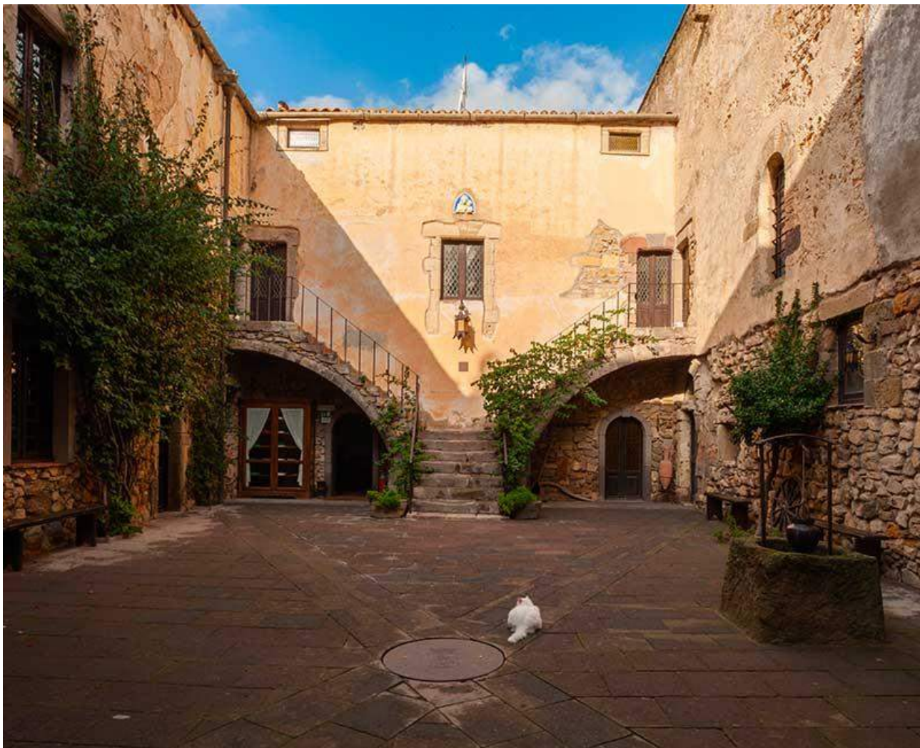
Figura 18 - Castello di Sanluri: corte interna (da web)
