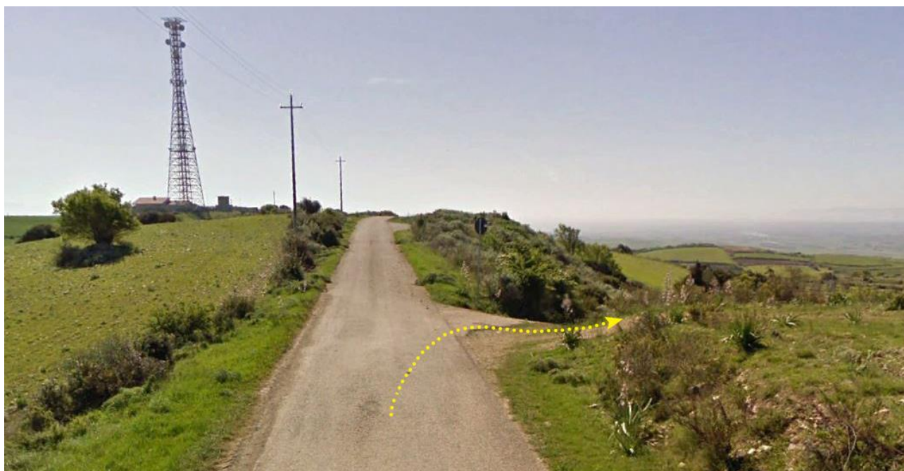
Figura 5.8 - Punto di accesso alle postazioni eoliche SR02 e SR01 (direzione sud-est)
