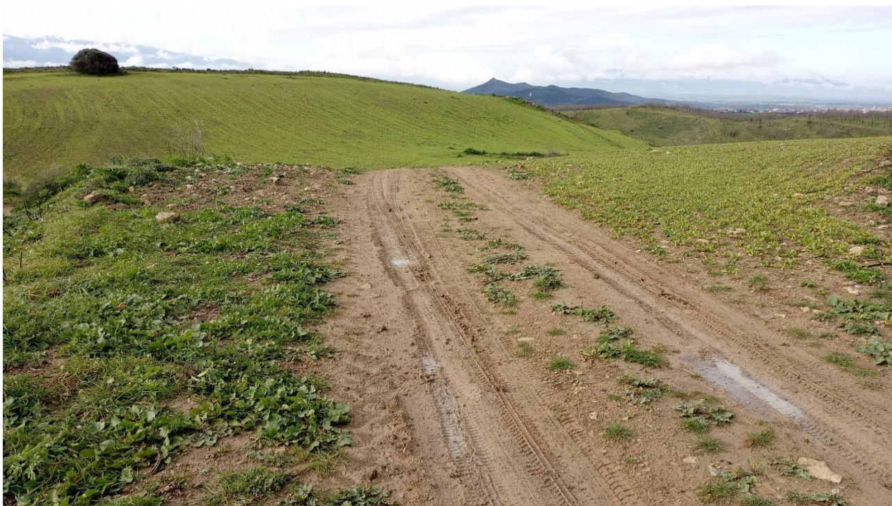
Figura 5.17 – Tracciato della viabilità esistente di collegamento alla postazione eolica SR03 (vista verso sud - ovest)
