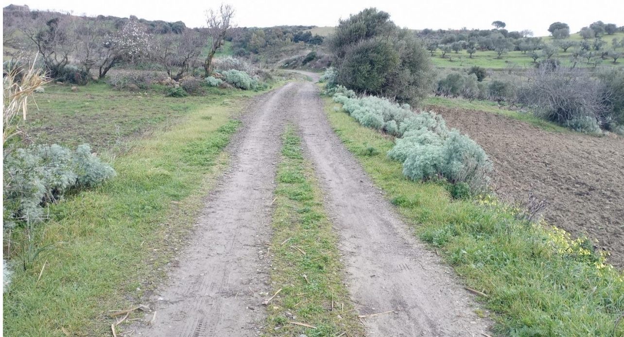
Figura 5.11 - Tratturo di viabilità esistente che si collega alla piazzola SR01 (direzione nord-ovest)
