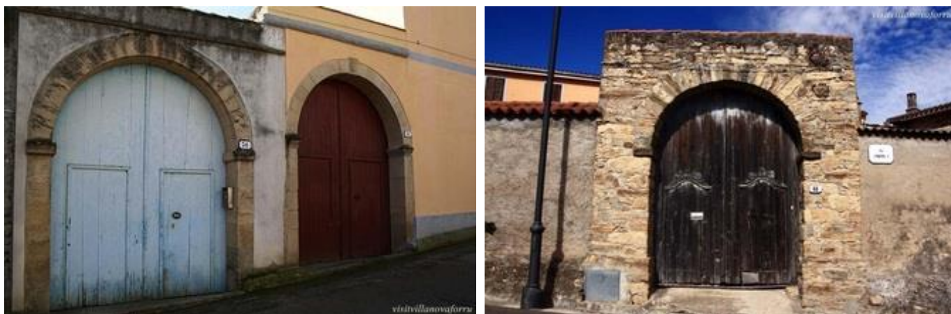
Figura 7.30 - Portali nel centro urbano di Villanovaforru (Fonte: visitvillanovaforru.weebly.com )
