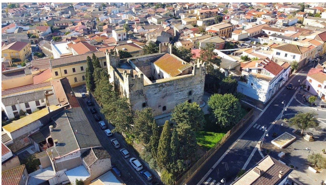
Figura 7.49 - Castello di Sanluri (Fonte: Sardegnaoggi.com)
