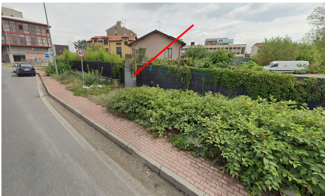
Figura 4-10 Servizio di trasporto e distribuzione del gas in prossimità dello svincolo sulla SS36
