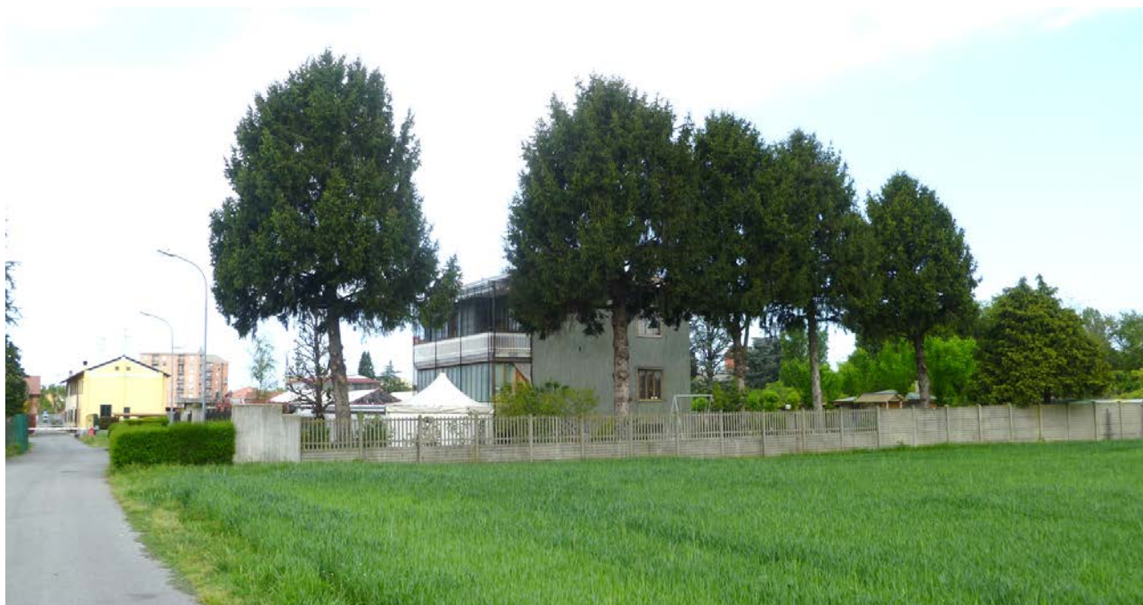
Figura 4.3 – Muri e recinzioni perimetrali degli insediamenti presenti al margine nord-occidentale dell'area del Casignolo che costituiscono barriera agli spostamenti terricoli degli animali (vista da via Trasimeno nell'immagine in alto, vista da via Aldina nell'immagine in basso)
