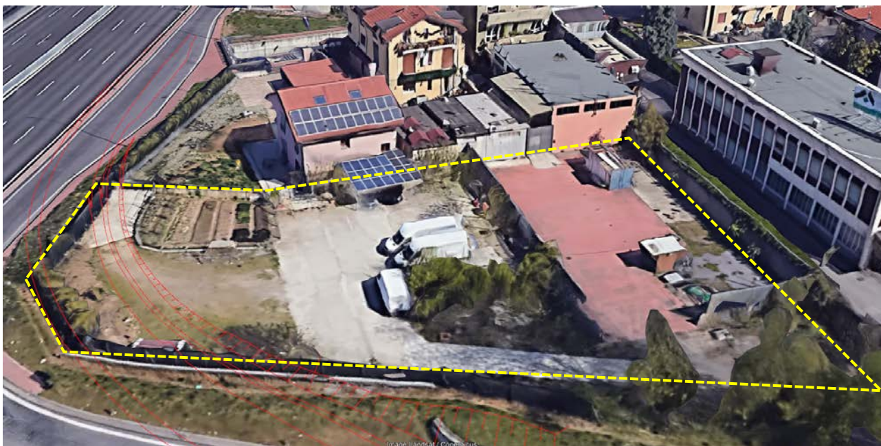
Figura 3.94 – Vista dell’area a lato della rampa A52 con presenza di diversi elementi segno di abbandono e di degrado
