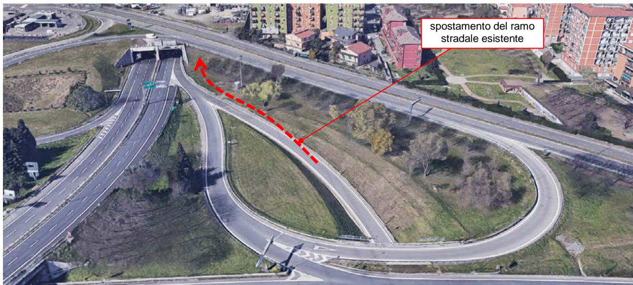
Figura 3.34 – Morfologie artificiali nell’ambito dello svincolo di Sant’Alessandro ove è previsto l’imbocco della nuova corsia in galleria (vista da est verso ovest)
