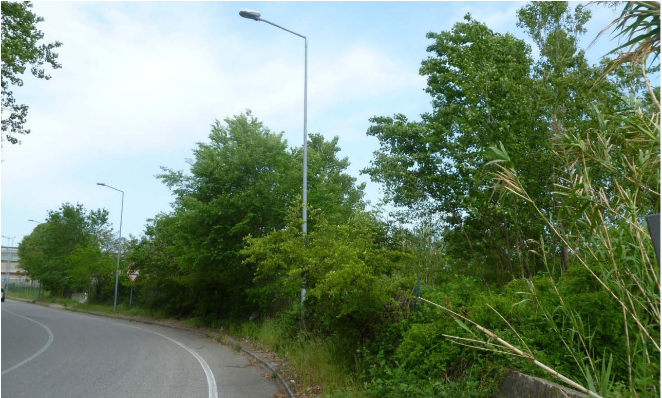
Figura 3.57 – Stato strutturale dell'unità lungo il margine a confine con la via Edison
