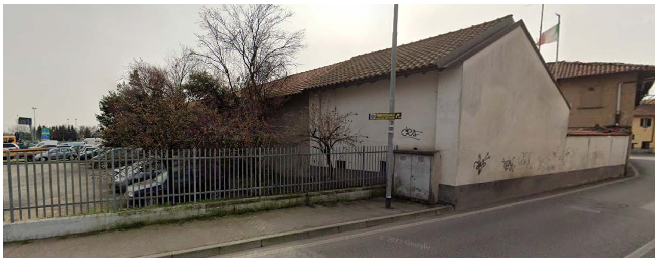
Figura 3.71 – Fabbricato nord di C.na S. Alessandro in prossimità di cui è prevista una porzione dell'area di cantiere funzionale alla realizzazione della nuova corsia in galleria
