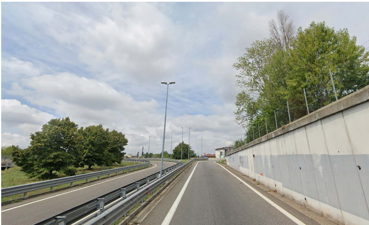
Figura 3.62 – Assetto vegetazionale ai lati della rampa di uscita dall’A52 allo svincolo con la SS36
