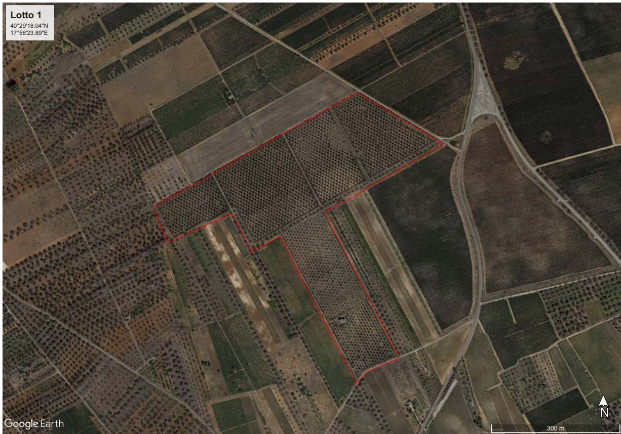
Figura 5 - Area Impianto LOTTO 1
