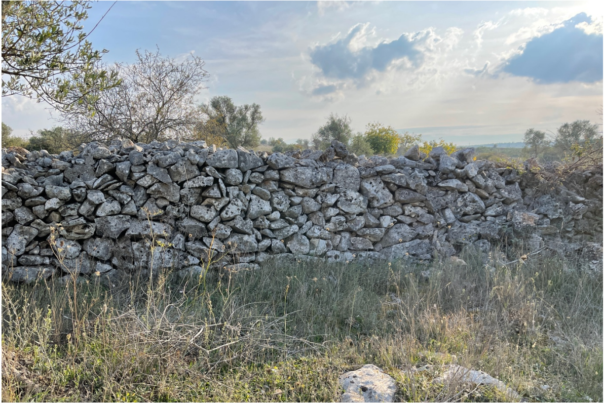
Figura 7 - Muretto a secco
