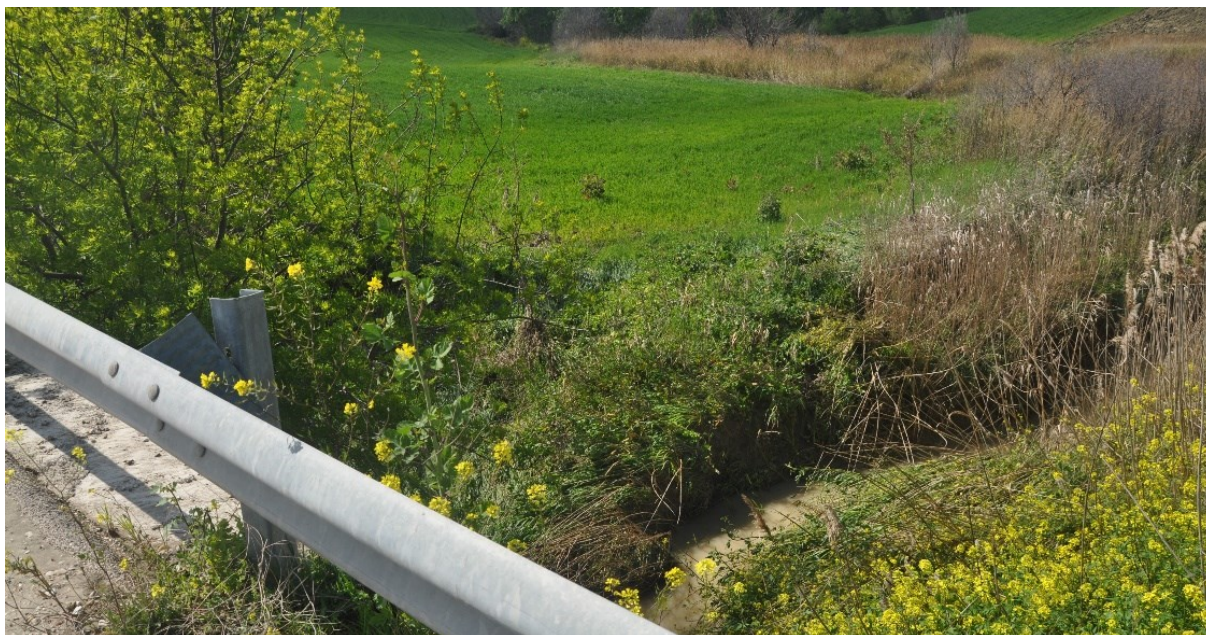
Figura 2-3: Fosso di Ionata, all'interno del proprio alveo, quasi tre metri al di sotto della strada asfaltata. La piana alluvionale è poco più elevata, oltre le piccole scarpate rese invisibili dalla vegetazione che le protegge.
