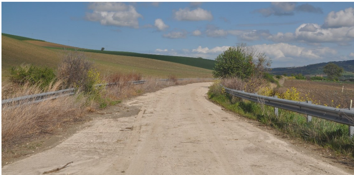
Figura 2-2: strada asfaltata (zona vincolata P1 e P2 da PAI e PGRA con stretta fascia centrale P3 in corrispondenza del ponticello), lungo cui avverrà la posa del cavidotto MT A tramite scavo a cielo aperto e ritombamento e staffatura.
