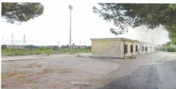
Fabbricato Viaggiatori esistente
