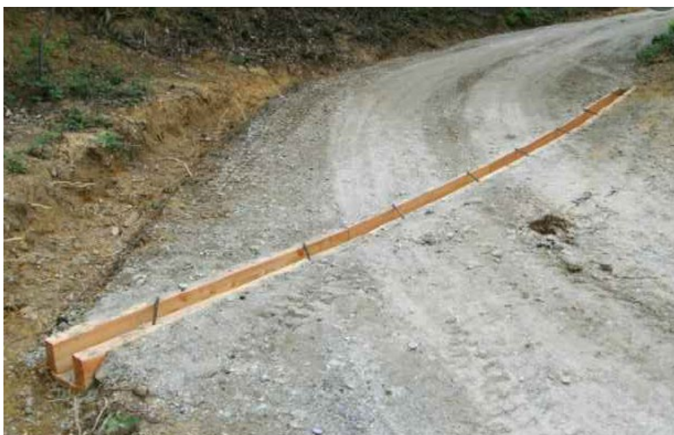
Figura 10-7 – Opere di regimentazione idraulica – rompiflusso in legno
