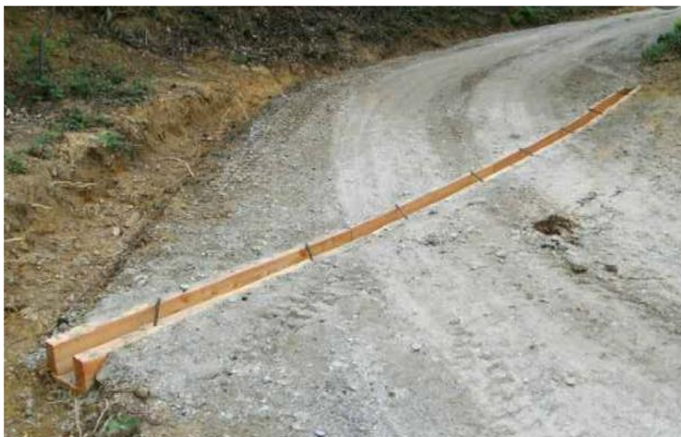
Figura 5-7 – Opere di regimentazione idraulica – rompiflusso in legno
