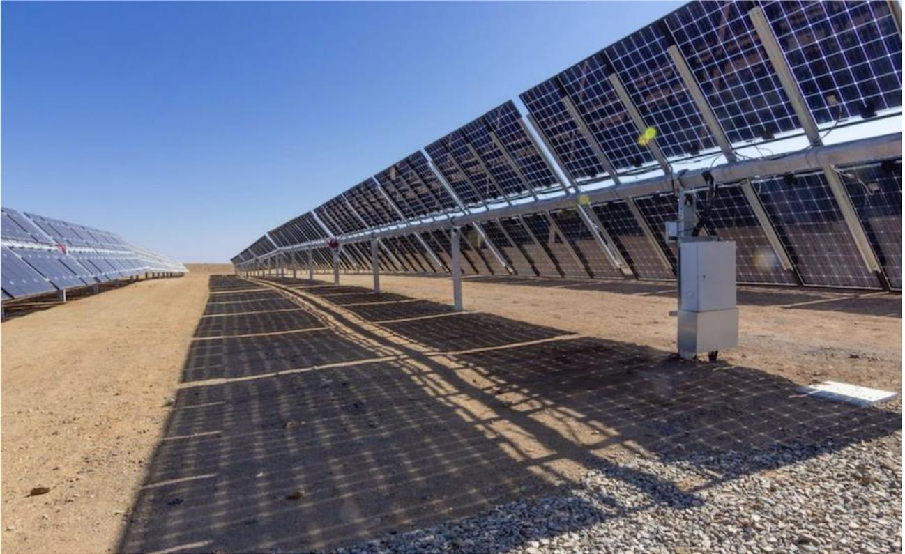
Figura 19 – Particolare strutture di sostegno impianto del tipo ad inseguimento monoassiale
