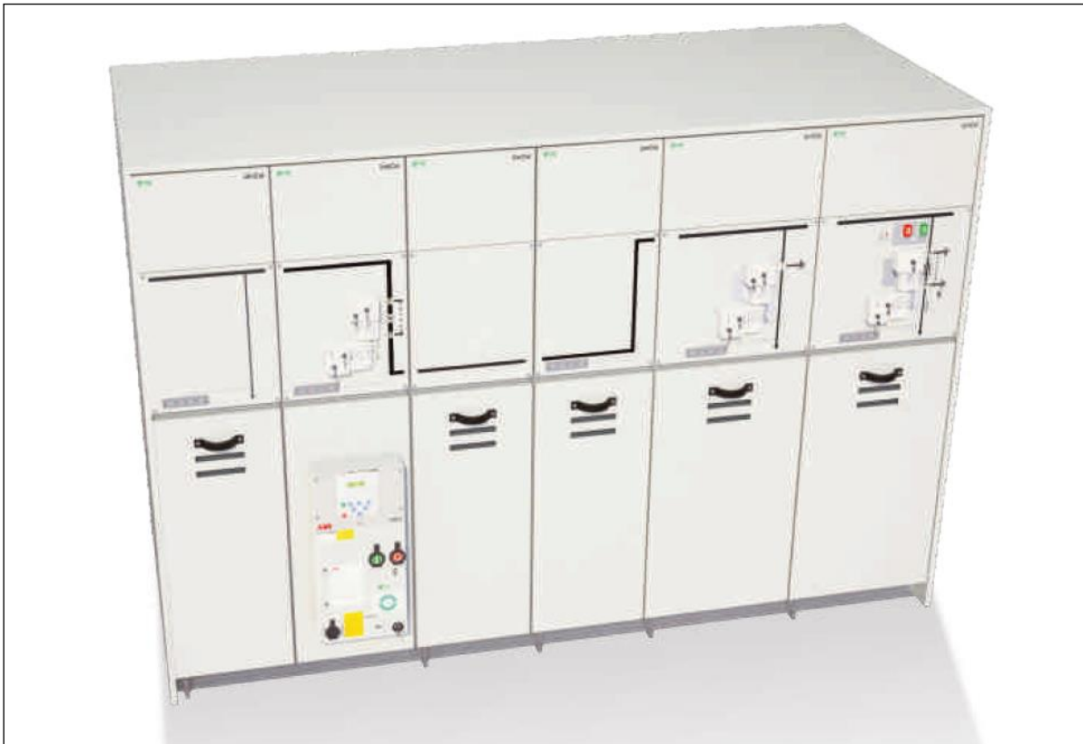
Figura 17: esempio tipico di quadro elettrico di MT
