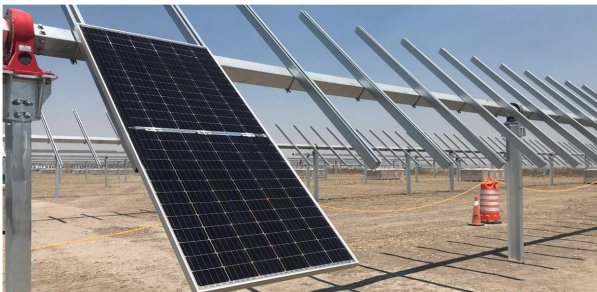
Figura 54 - Montaggio tracker
