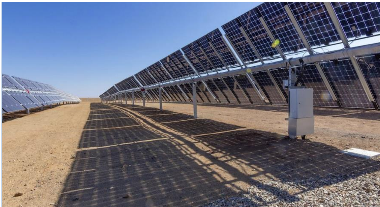
Figura 68 – Particolare strutture di sostegno impianto del tipo ad inseguimento monoassiale
