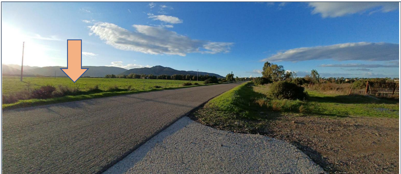
Figura 15 - PDV 6, Stato di fatto
