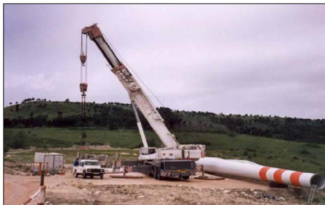
**Figura 2 – autogru di montaggio**
