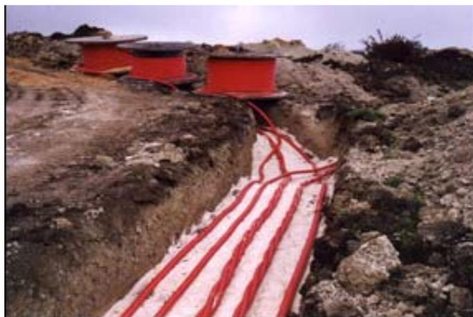
Figura 1 – Posa dei cavidotti interrati
