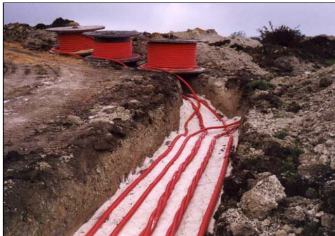
Figura 1.4.7.-1.: Particolare della posa cavi elettrici.
