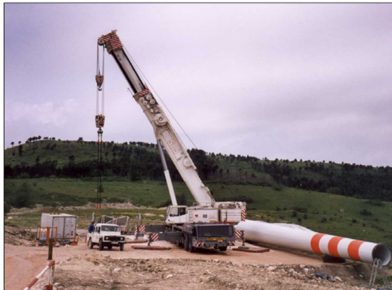
Figura 1.4.6.-1.: Fase di montaggio di un aerogeneratore.
